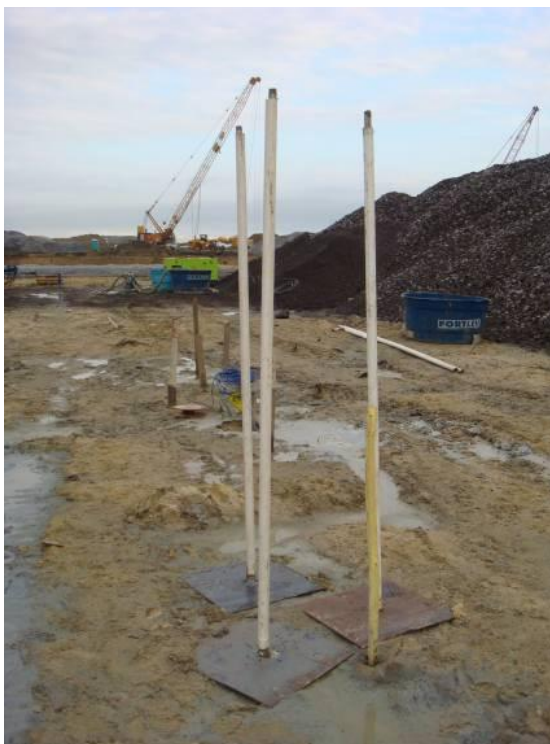
Figura 14 – Placas de recalque típicas
