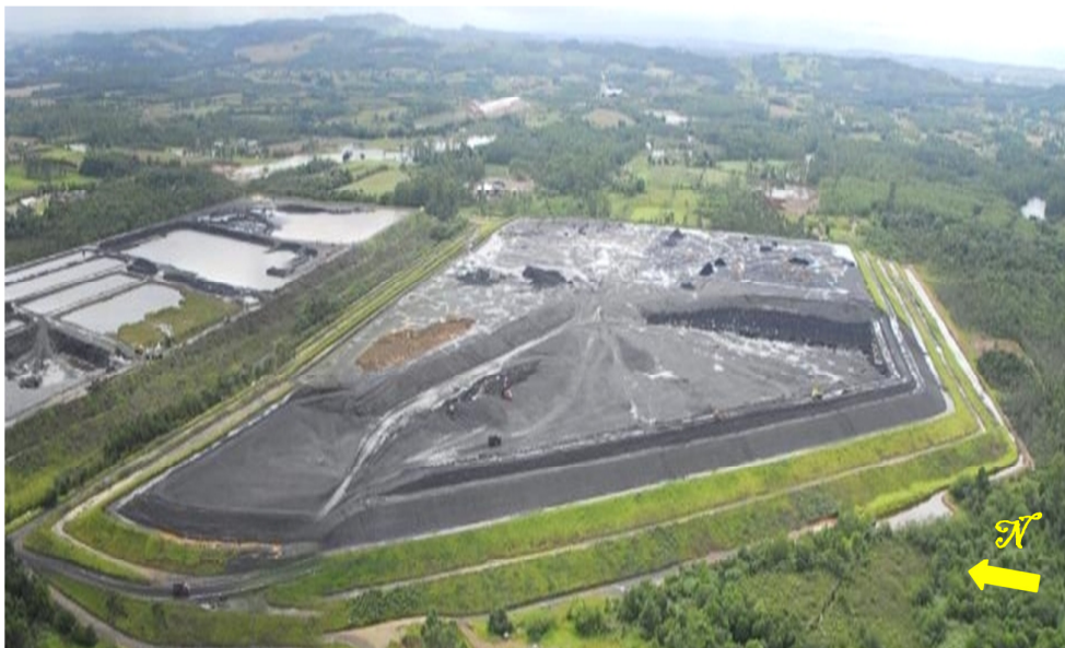
Figura 28 Vista superior da área utilizada para disposição final de rejeitos. À esquerda, as bacias de sedimentação utilizadas para a separação sólido-líquido. À direita: módulo B de rejeitos. Fonte: cortesia CCSA.
