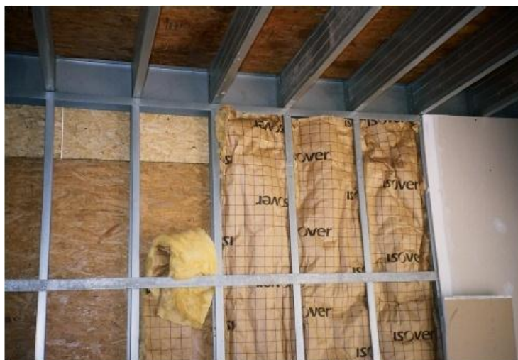
Figura 37 – Isolamento termoacústico com lã de vidro
