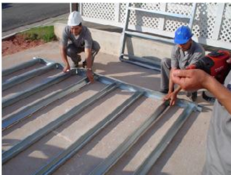
Figura 9 – Montagem do painel pelo método stick no canteiro de obras
