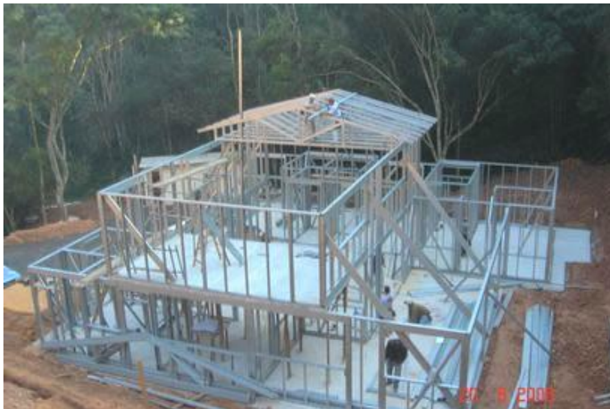
Figura 2 – Estrutura em LSF
