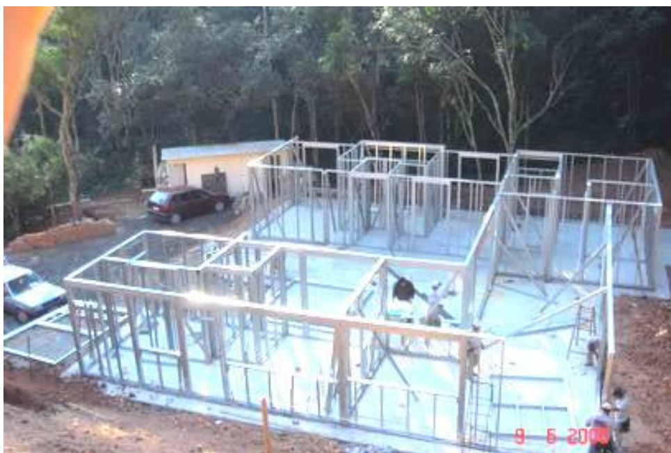
Figura 21 – Estrutura formada pela ligação dos painéis
