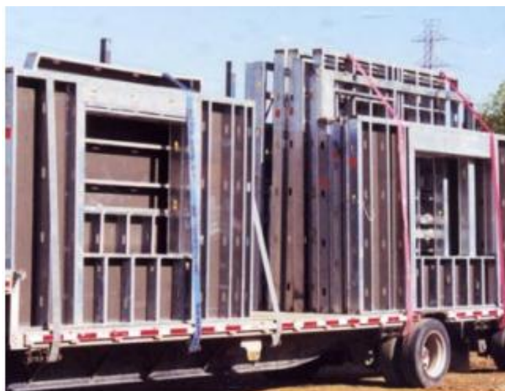
Figura 10 – Painéis prontos levados até a obra
