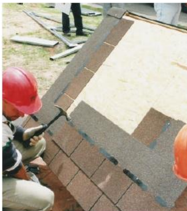
Figura 26 – Aplicação de telha shingle sobre placas OSB com isolamento hidrófugo
