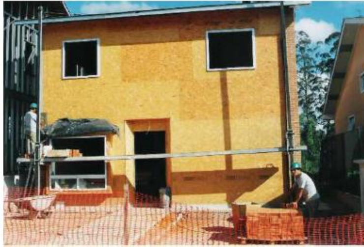
Figura 20 – Contraventamento com placas de fechamento estrutural
