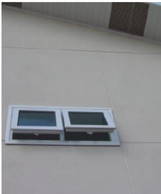
Figura 32 – Fachada em OSB revestida com argamassa
