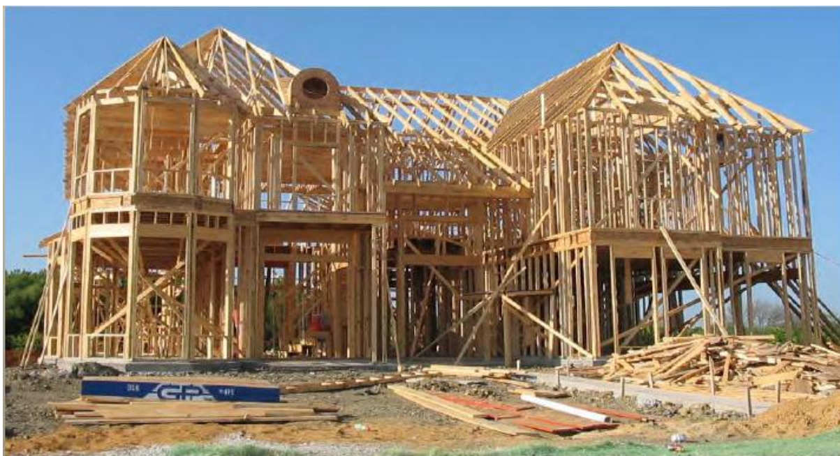
Figura 4 – Construção em wood frame
