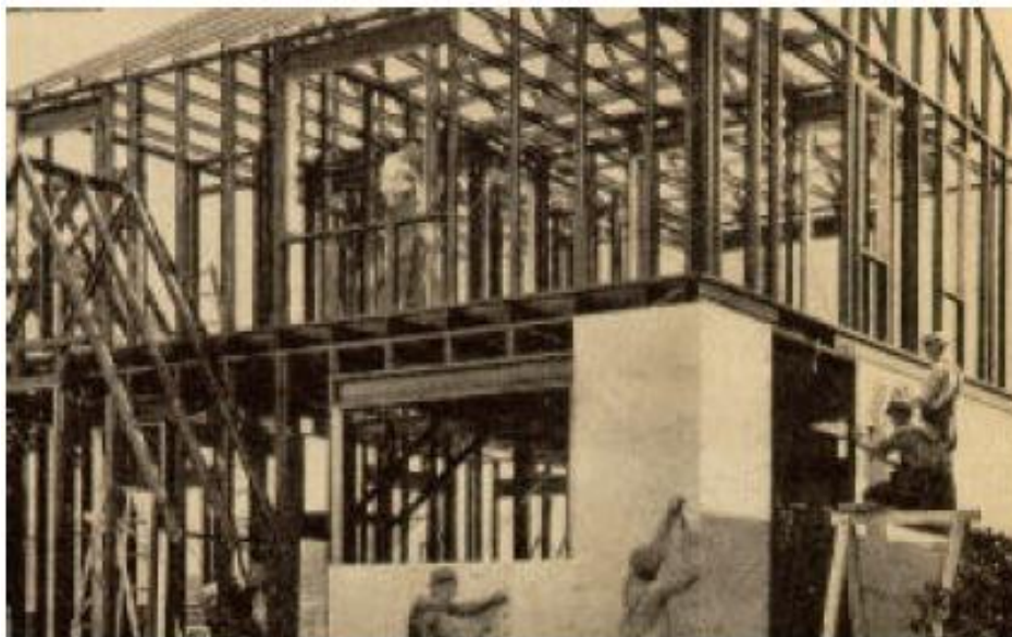
Figura 5 – Protótipo residência em LSF
