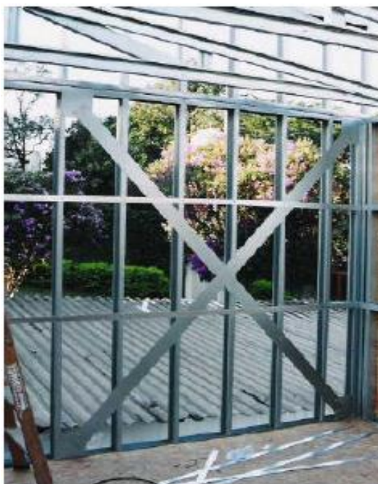
Figura 19 – Contraventamento em X
