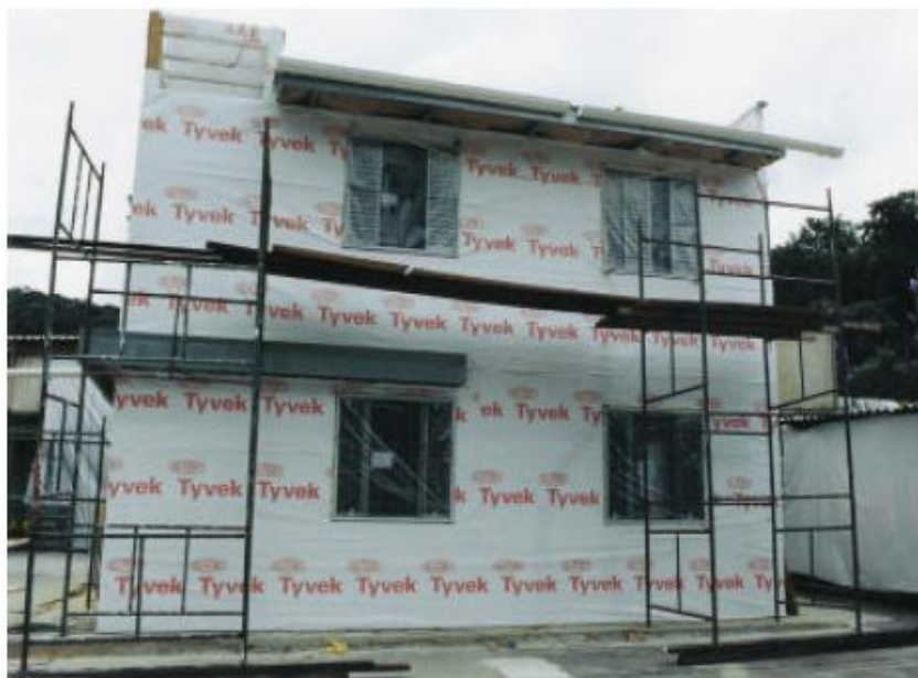
Figura 29 – Impermeabilização das placas OSB com membrana de polietileno
