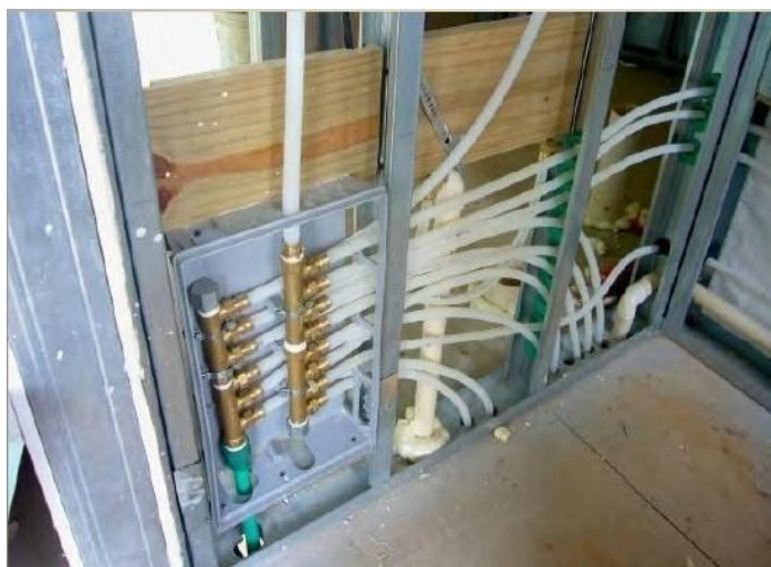
Figura 38 – Instalações hidráulicas inovadoras incorporadas no LSF
