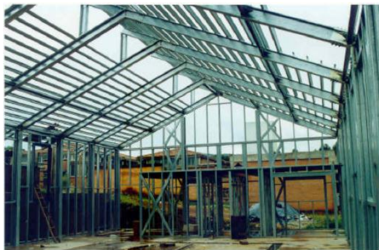
Figura 25 – Estrutura telhado inclinado
