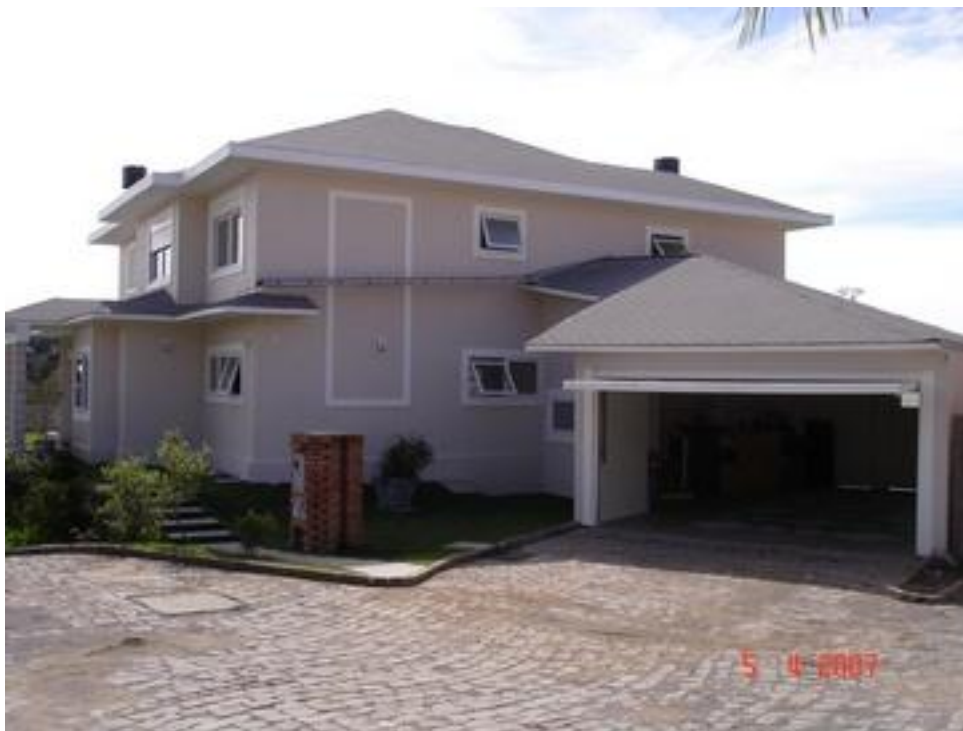
Figura 3 – Residência construída em LSF
