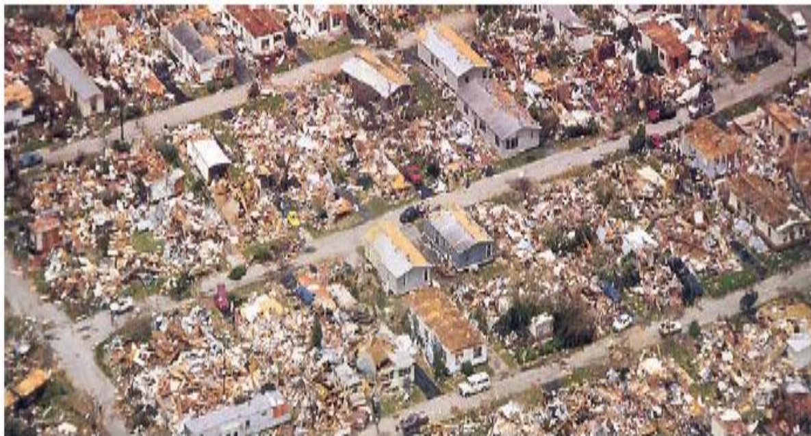
Figura 6 – Destruição causada pelo furacão na Flórida
