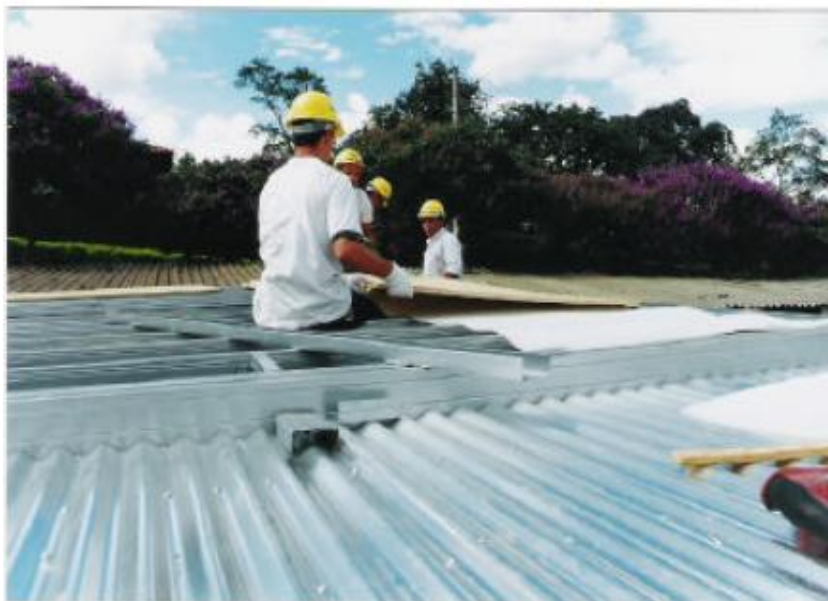
Figura 22 – Montagem laje úmida
