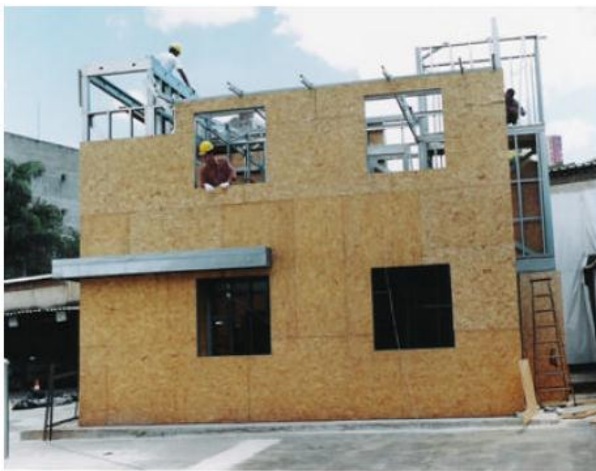
Figura 28 – Fechamento externo com painéis OSB
