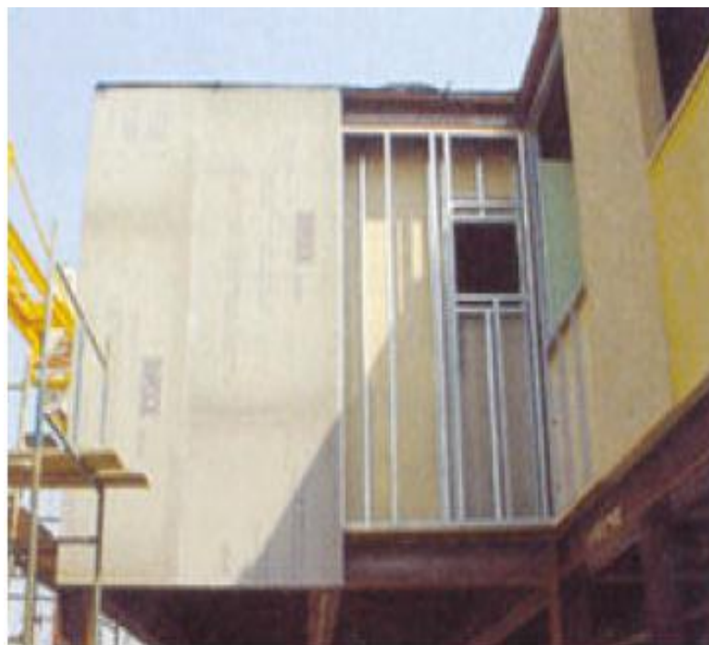
Figura 34 – Fechamento externo com placas cimentícias
