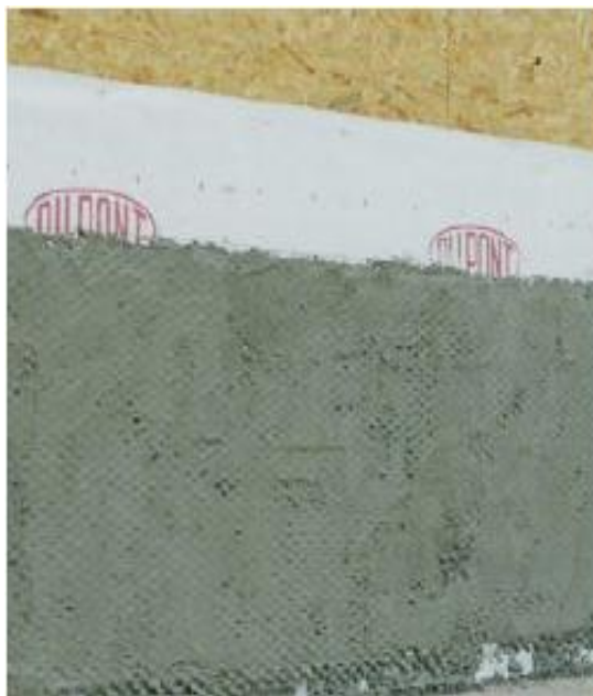
Figura 31 – Revestimento em argamassa aplicado sobre tela fixada na membrana e na placa OSB
