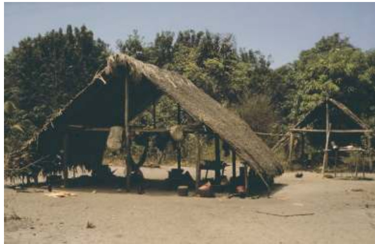
Figure 21. Carbet Kaliña avec son toit à double pente. Photo: Pr. G. Larrouy (1962). Notez toutefois que les extrémités de ces carbets ne sont pas fermées
