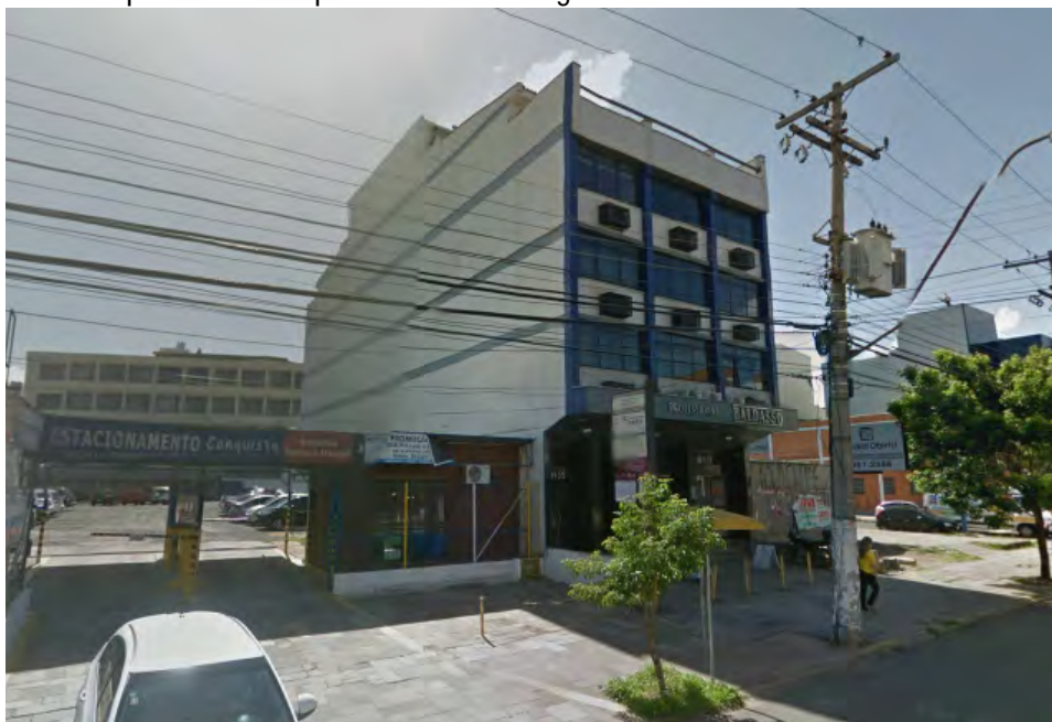
3. vista av. Assis Brasil - divisa com prédio comercial
