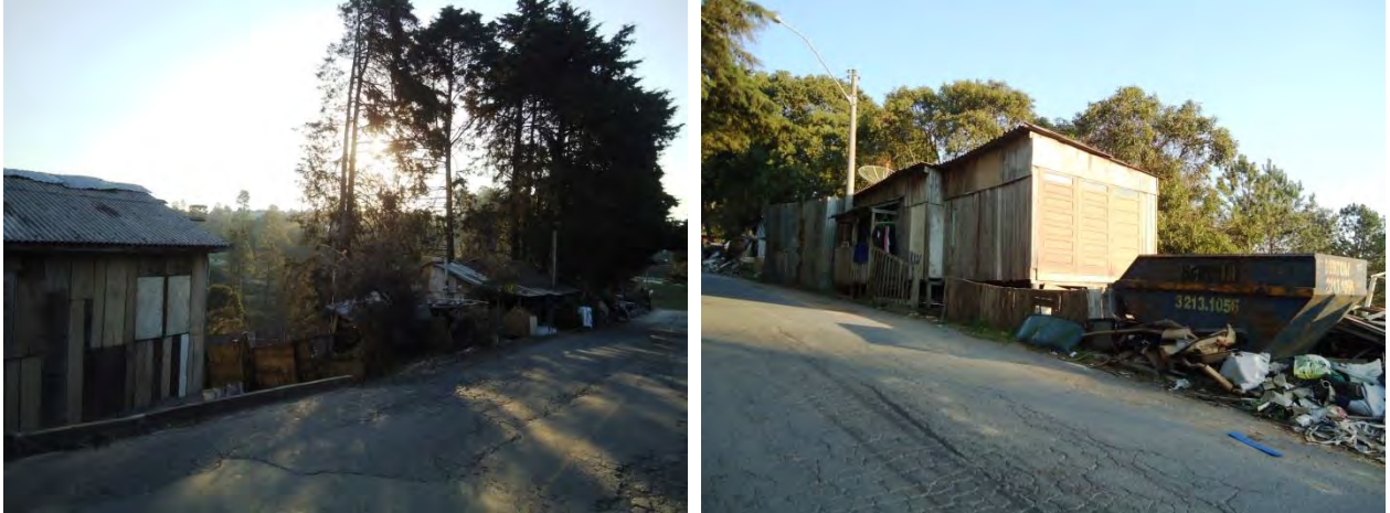
Moradias irregulares em loteamento próximo à BR-453.
