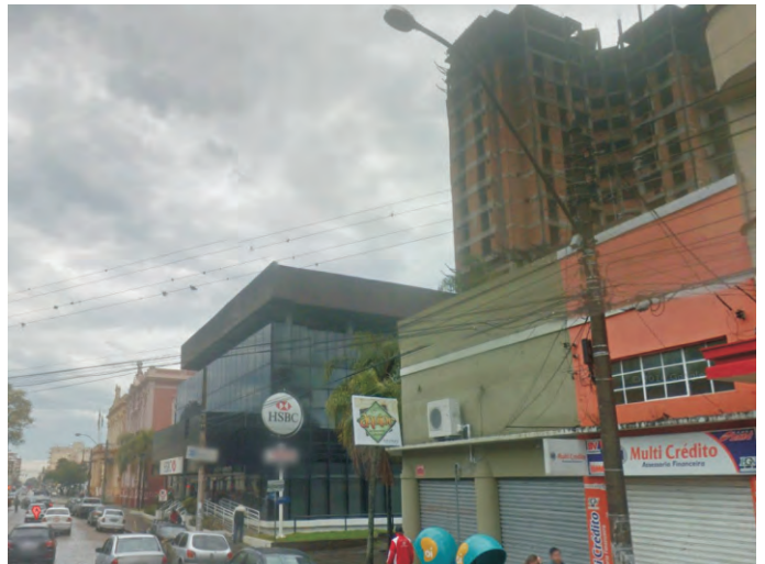
Rua XV de Novembro: agência bancária e torre inacabada
