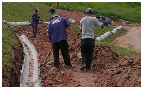
Figura 2.7: Canalização de águas pluviais. (Fonte: CIAS, 2003).
