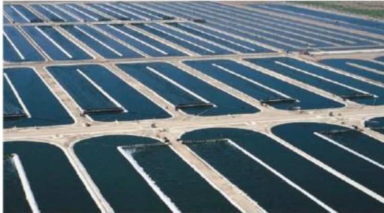
Figura 2.2: Cultivo de microalgas em lagoas "raceway"
