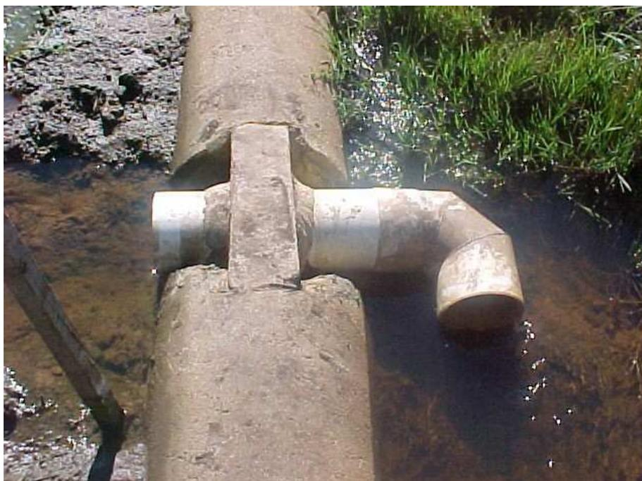
FIGURA 33: Sistema de taipas do Banhado 4. (A) construção das taipas em dezembro de 2000; (B) detalhe do sistema que permite o controle do nível d'água para manejo do sistema.
