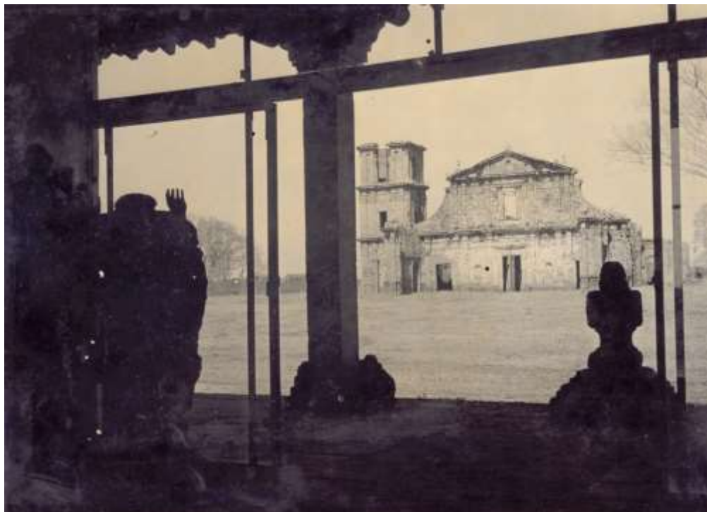
Fotografia 51- Tomada interna com vista em diagonal feita do interior da sala 02.
