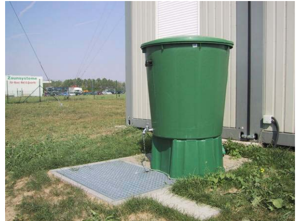
Depósito de água potável do sistema de tratamento
