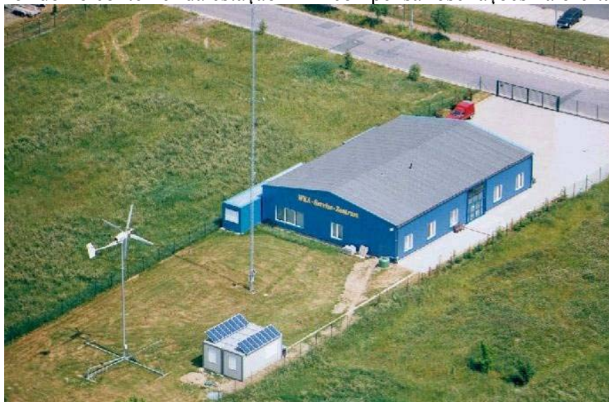
Vista aérea da completa estação híbrida experimental e da torre de medição para o registro das situações locais do vento, da temperatura, bem como da pressão do ar
