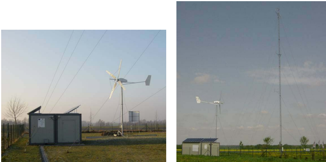
Figura 26: Sistema híbrido de ensaio completamente instalado com aerogerador de pequeno porte (altura do cubo de 7 m à esquerda e de 13 m à direita) e mastro de medição para o registro de velocidade do vento, direção do vento, temperatura e pressão do ar
