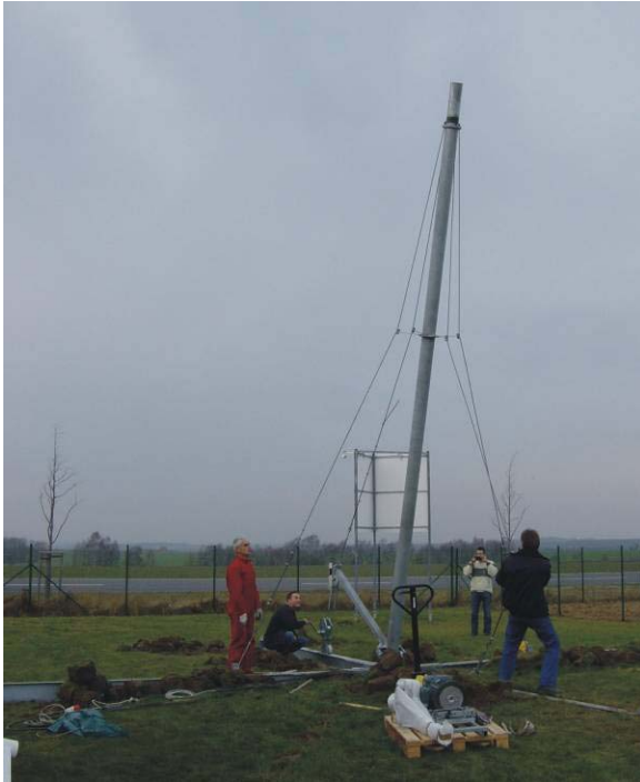
Montagem do mastro ancorado do aerogerador de pequeno porte com o guincho do dispositivo de montagem integrado na torre
