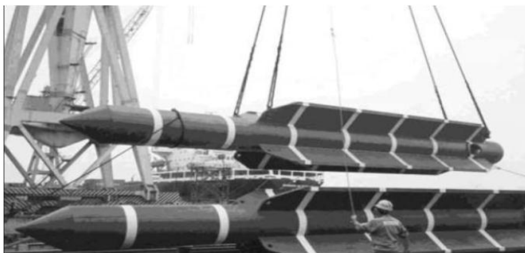
Figura 8 – Estacas torpedo utilizadas pela Petrobras
