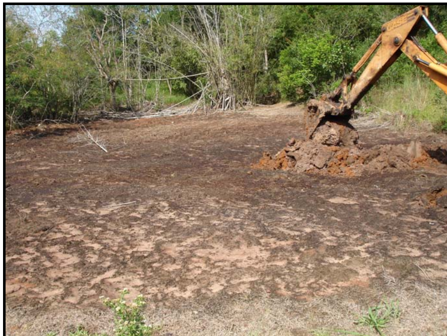
Figura 3.9: Escavação para a coleta do solo.
