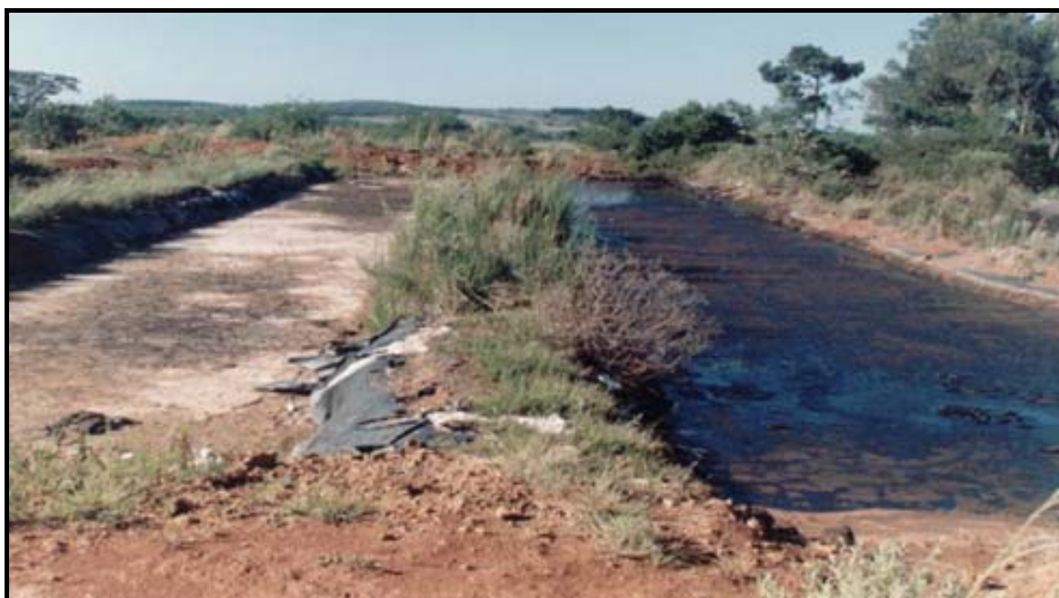
Figura 3.2: Valas preenchidas com borra ácida (SILVA, 2005).
