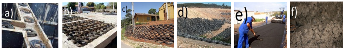
(a) Uso como agregado de baixo peso para preenchimento; (b) Uso em lajes de reação (c) Uso como suporte de muros de contenção; (d) Uso em aterros; (e) Uso em asfaltos como revestimento; (f) Fibras de aço do pneu misturadas no concreto.
