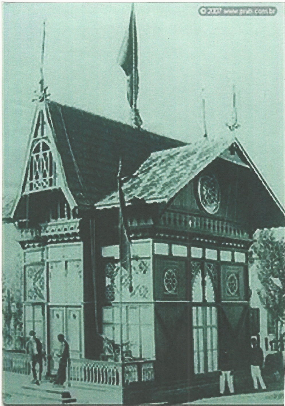
PAVILHÃO RHEINGANTZ (RIO GRANDE)
