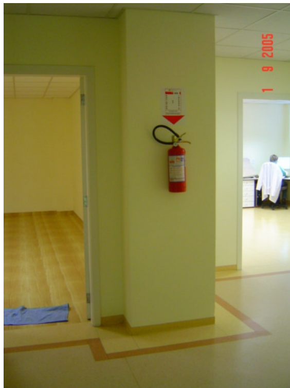
Figura 53: fixação de elemento de peso elevado em pilar de concreto
