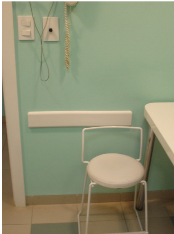
Figura 46: solução do problema de descolamento da pintura da parede de gesso acartonado devido a batidas de cadeiras
