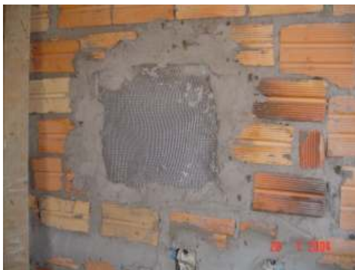
Figura 11: Tela fixada com argamassa
