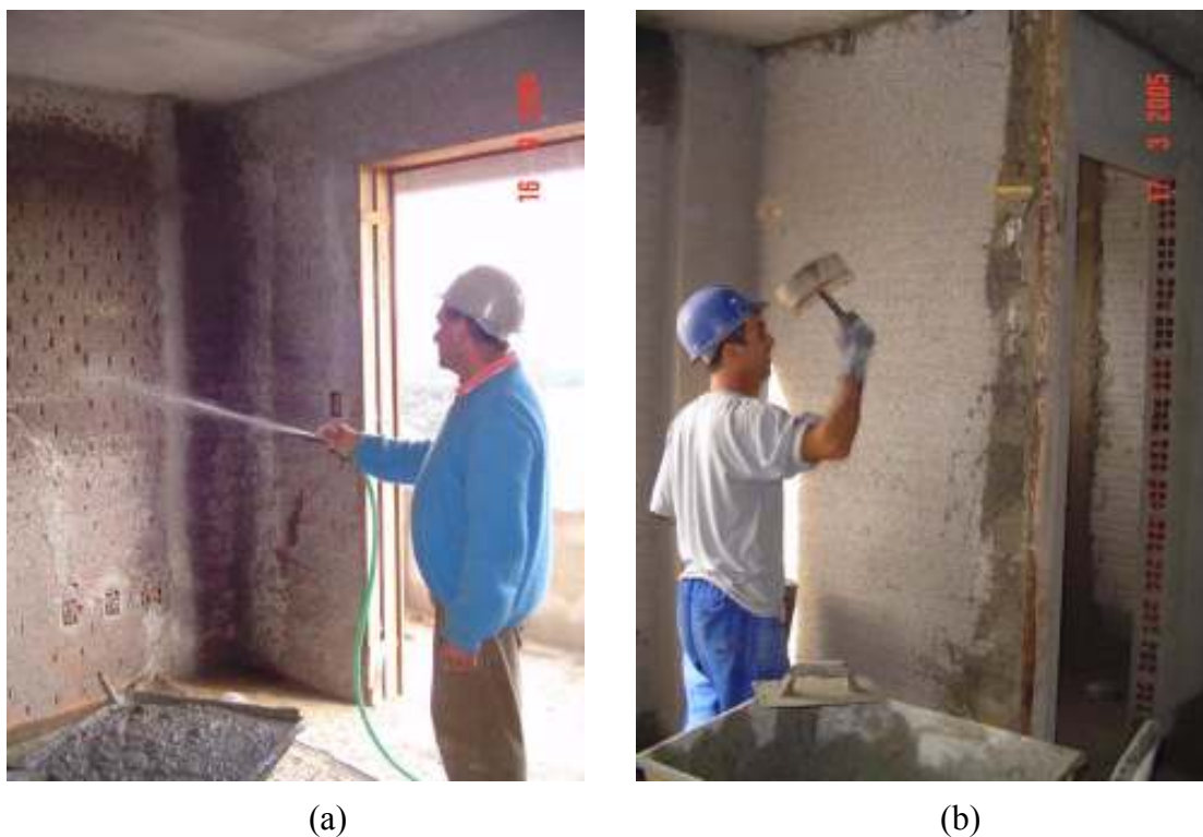
Figura 19: Umedecimento do substrato com o auxílio de (a) mangueira; (b) trincha
