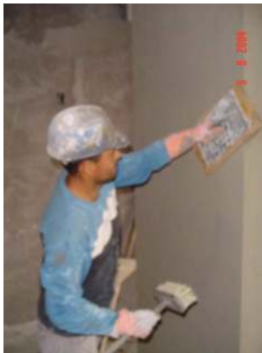
Figura 22 - Superfície que irá receber pintura com tintas minerais, látex PVA ou acrílico, sobre massa corrida ou textura acrílica em uma única demão: desempenho com PVC, seguido de desempenho com espuma
