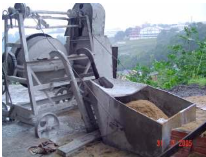
Figura 13: Betoneira com caçamba de carregamento
