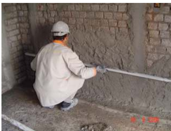
Figura 20 – Retirada do excesso de argamassa por meio do sarrafeamento
