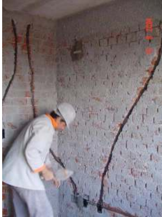
Figura 9 – Execução das tubulações embutidas antes da execução do revestimento
