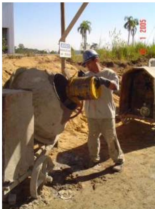
Figura 16 – Dosagem da água sem precisão, por meio de baldes
