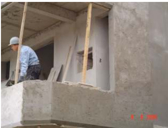
Figura 21 – Superfície que irá receber revestimento cerâmico: desempenho somente com a régua
