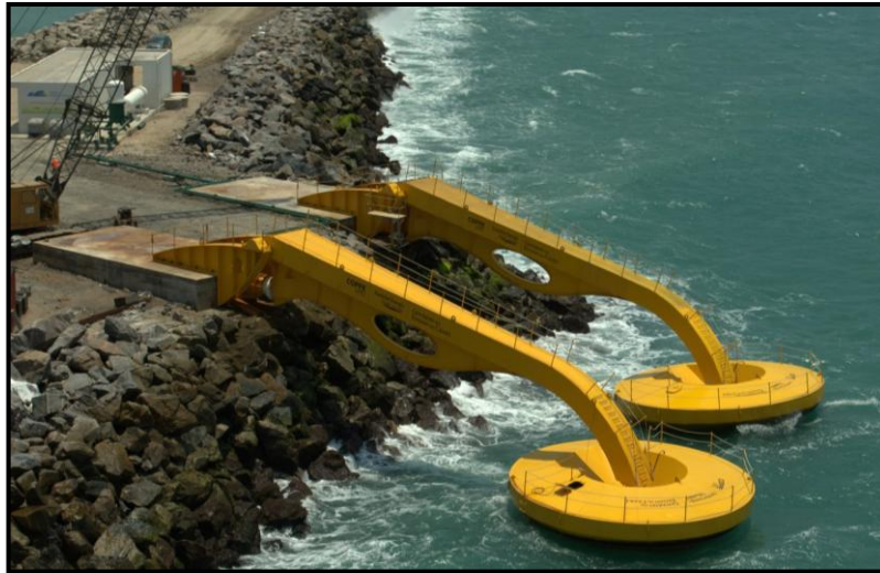
Figura 5.58: Usina (protótipo) de conversão das ondas do mar desenvolvida pela COPPE e implantada no Porto do Pecém/Ceará.
