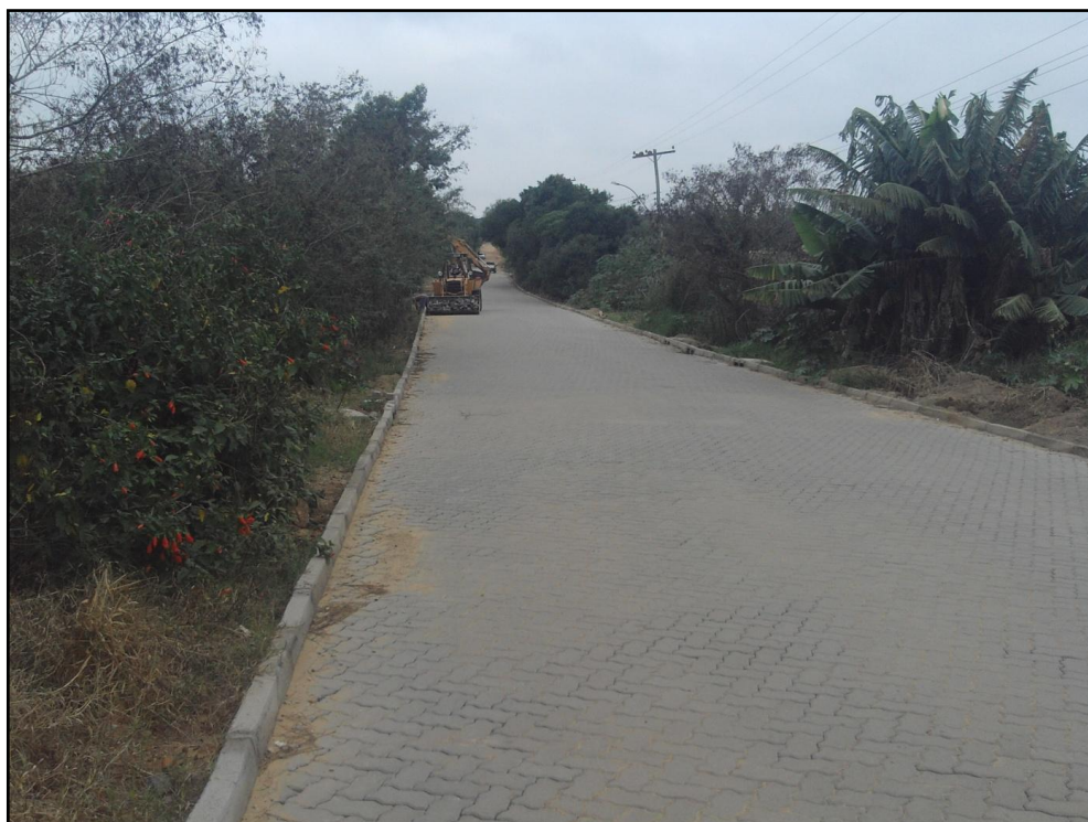
Figura 25 - Via em pavimentação
