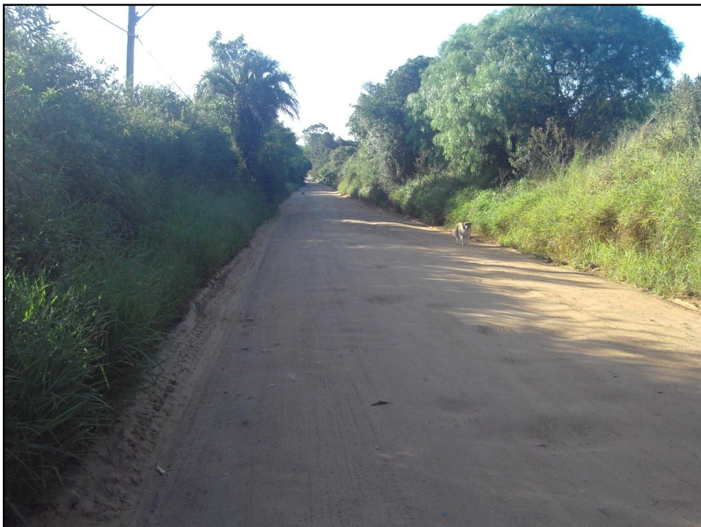
Figura 24 - Via não pavimentada
