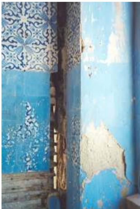
Figura 35: Sobrado dos Azulejos – salinização nos rebocos
