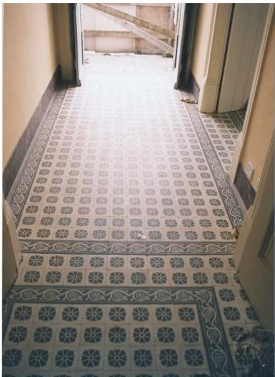
Figura 27: Sobrado dos Azulejos – piso de ladrilho hidráulico
