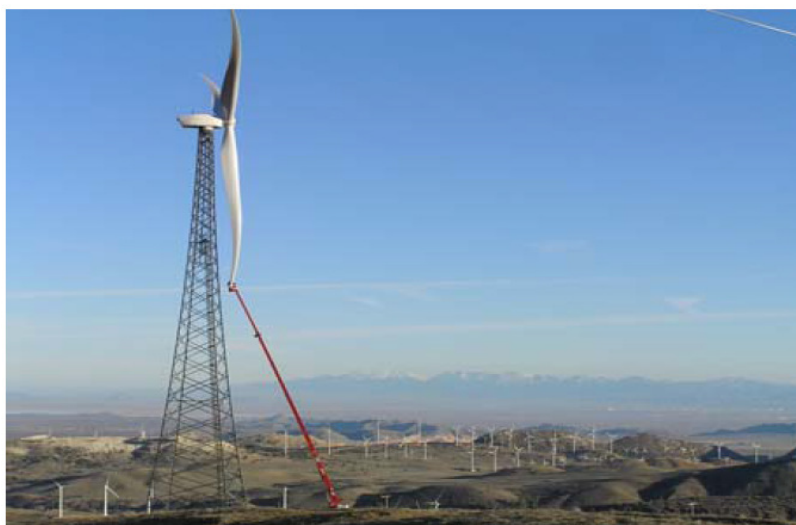
Figura 6.11 - Pá Deformável em Teste na Califórnia Fonte: (ASHWILL, 2009)
