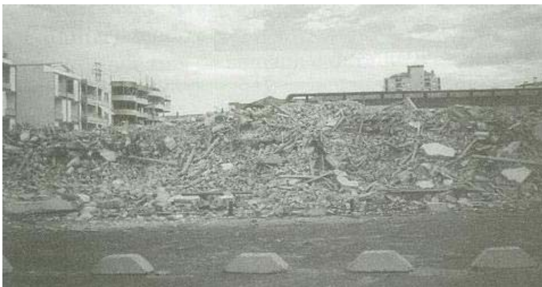
FIGURA 5.15 – Demolição do Hotel Riograndense (2003) - Capão da Canoa
