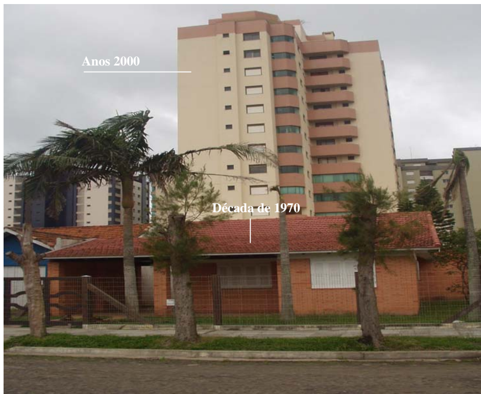
FIGURA 5.17 – Gabaritos diferenciados no Bairro Navegantes – Capão da Canoa
