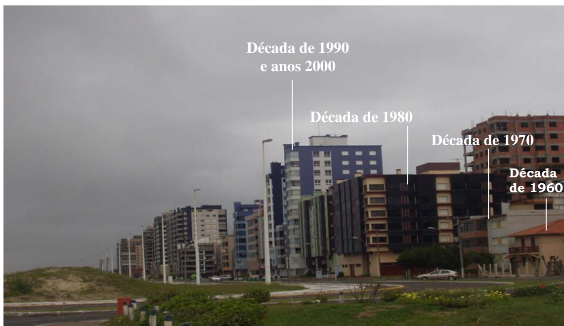
FIGURA 5.18 – Gabaritos diferenciados na Av. Moema no Bairro Navegantes – Capão da Canoa
