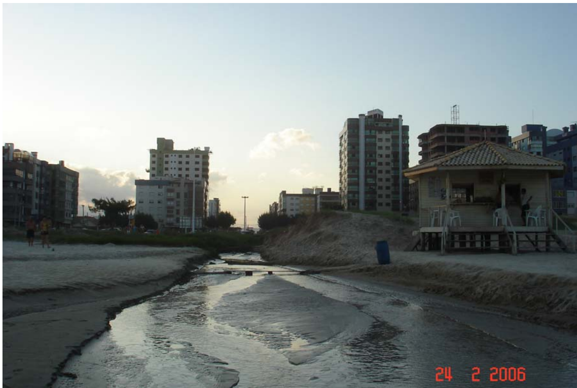
FIGURA 5.44 – Escoamento pluvial para a praia no eixo da Praça Luiz Bassani em Capão da Canoa
