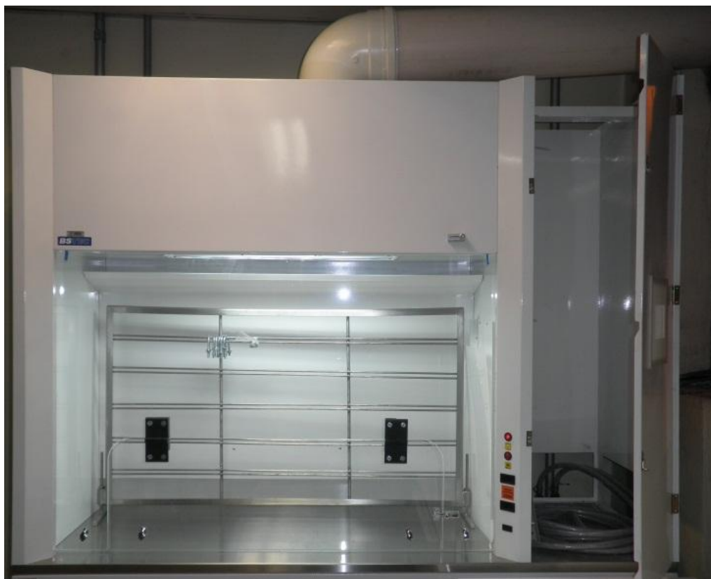
Figura B16: Capela de exaustão de gases.
