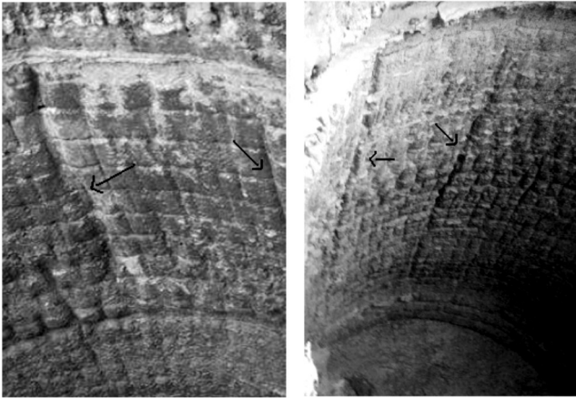
Figura 5: Desgaste excessivo devido à presença de fluorita em condição de mistura insuficiente.
