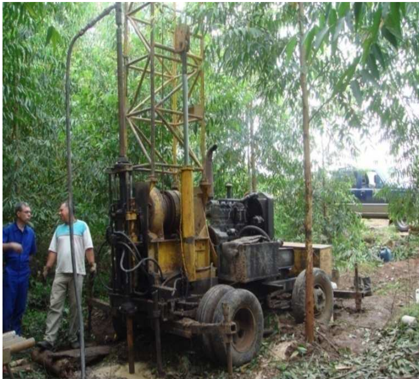
Figura 4.5: Perfuratriz Sullivan 22 usada para a execução dos furos de sondagem.
