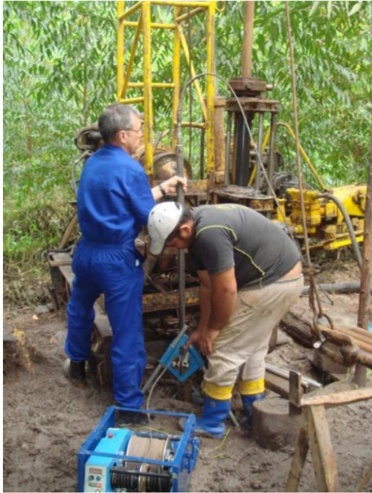
Figura 3.3: Sonda GLOG® sendo introduzida no furo de sondagem.
