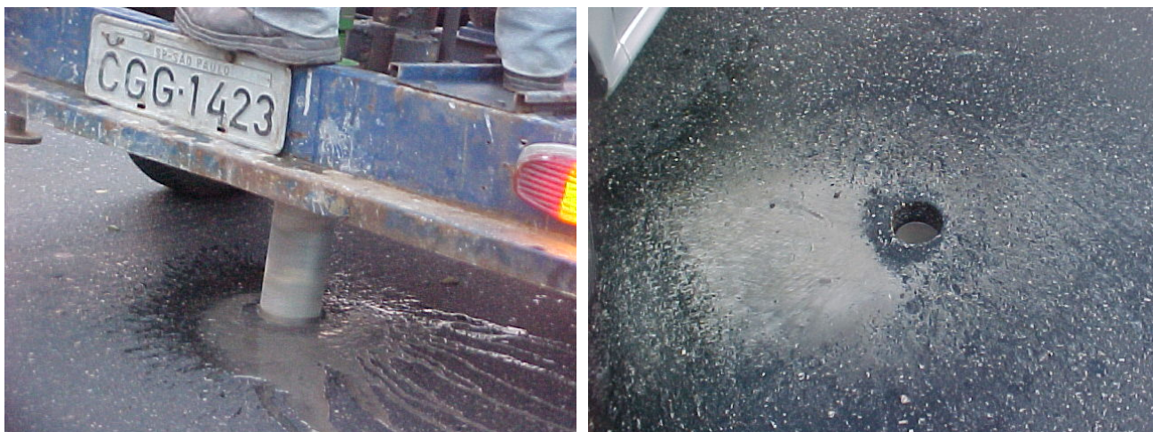
Fig.3.10 – Sondagens rotativas executadas na Avenida dos Bandeirantes.
