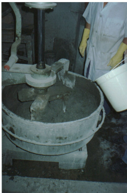
Figura 4.16 - Mistura da argamassa de reforço
