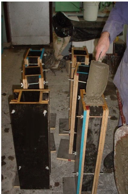
Figura 4.3 - Concretagem dos pilares
