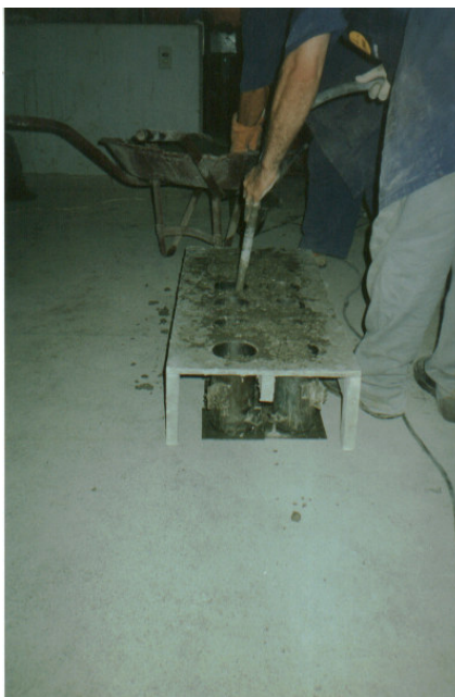
Figura 4.4 - Moldagem dos corpos-de-prova de controle do concreto
