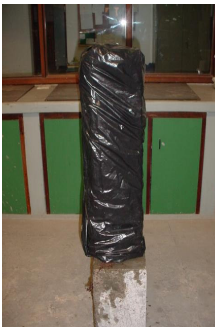
Figura 4.22 - Cura dos pilares reforçados
