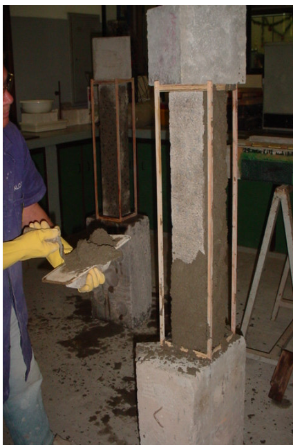
Figura 4.20 - Pilares sendo reforçados
