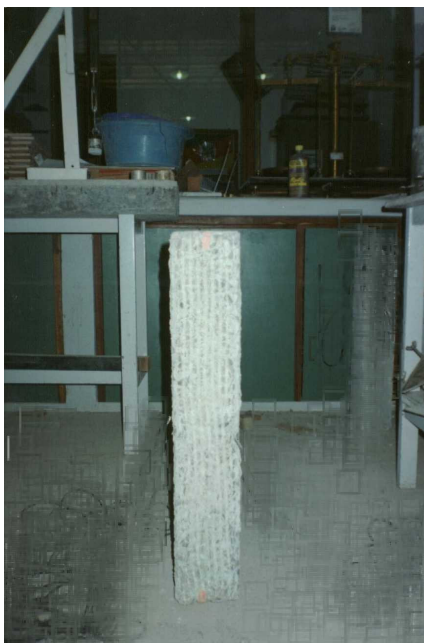
Figura 4.15 - Pilar apicoado pronto para receber o reforço de argamassa
