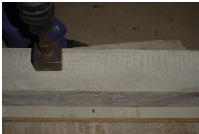
Figura 4.13 - Apicoamento do pilar
