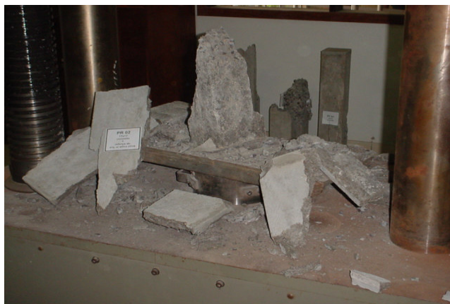
Figura 5.8 - Ruptura do pilar reforçado PR 02
