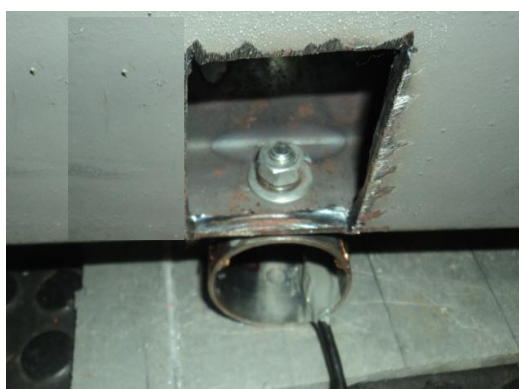
Figura 3.8 – Montagem da célula de carga na plataforma.
