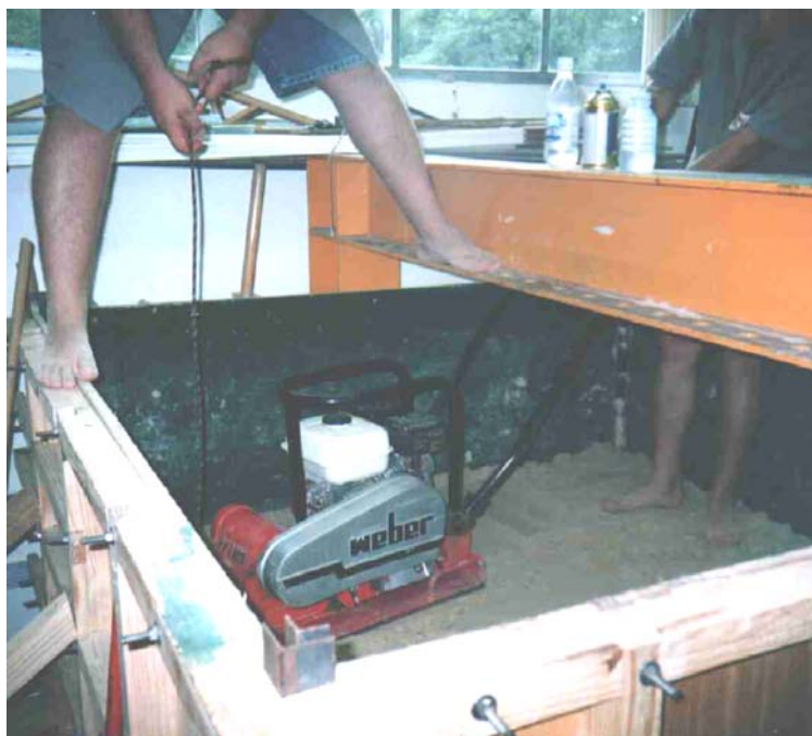
Figura 3.14: Detalhe do processo de compactação das camadas.
