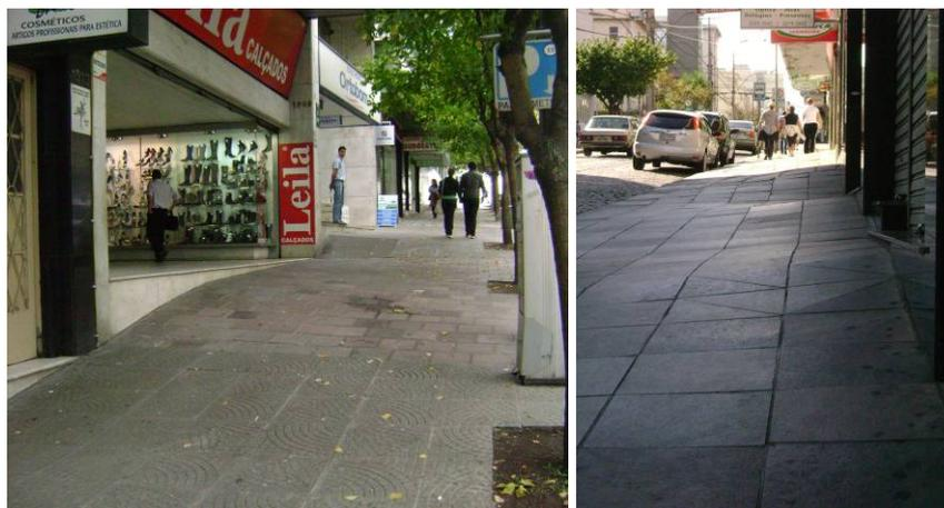
Figura 16 – Exemplos dos problemas observados nos passeios quanto a sua inclinação longitudinal
