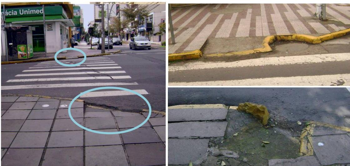
Figura 19 – Exemplos de rebaixos deslocados e fora dos padrões da NBR9050
