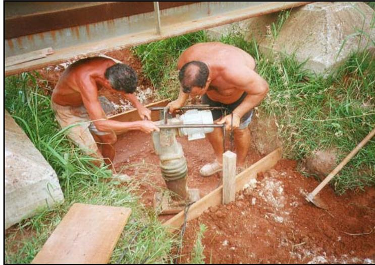
Figura 3.6 – Compactação das camadas sob a viga de reação.
