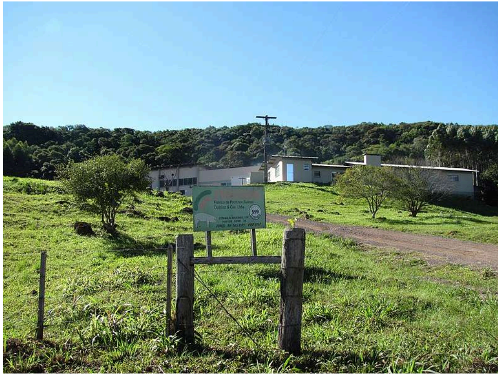
Figura 15: Frigorífico Dalpiaz. – FRIGODAL
