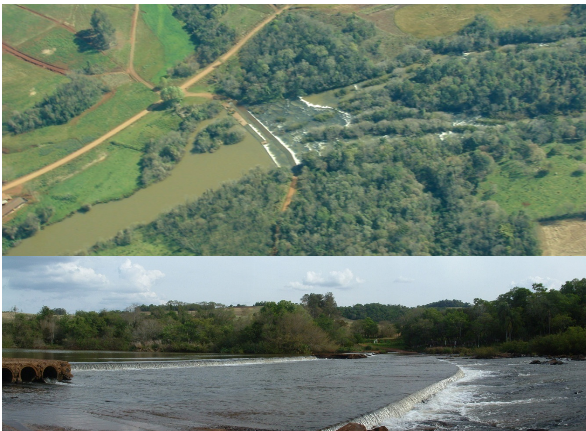
Figura 6. Vista aérea e aspecto local da barragem de concreto instalada para a passagem de veículos no rio Erechim (UTM 22J 6944572/336799).
