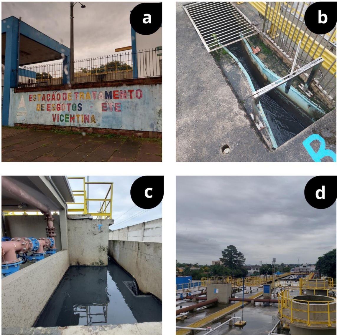
Figura 6 - Estação de Tratamento de Esgotos Vicentina (São Leopoldo – RS), onde: (a) fachada da entrada, (b) calha Parshall, onde foi realizada a coleta de efluente bruto, (c) local de coleta de amostras pós-tratamento e (d) vista geral da ETE.
