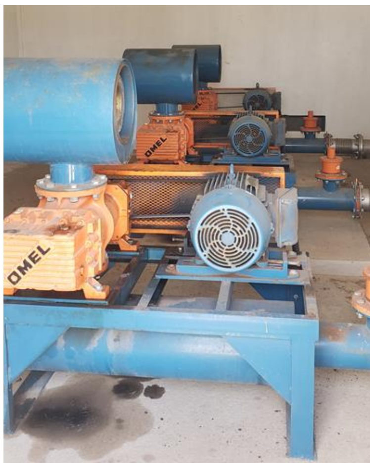
Figura 4. Casa dos sopradores.
