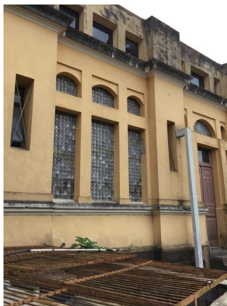
Figura A27 – Reentrâncias laterais e saliências da ala esquerda da ala esquerda da fachada sul – trecho t3 - vista 2
