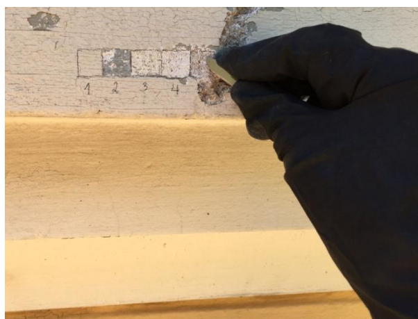
Figura 97 - Execução do ensaio de prospecção estratigráfica de pintura
