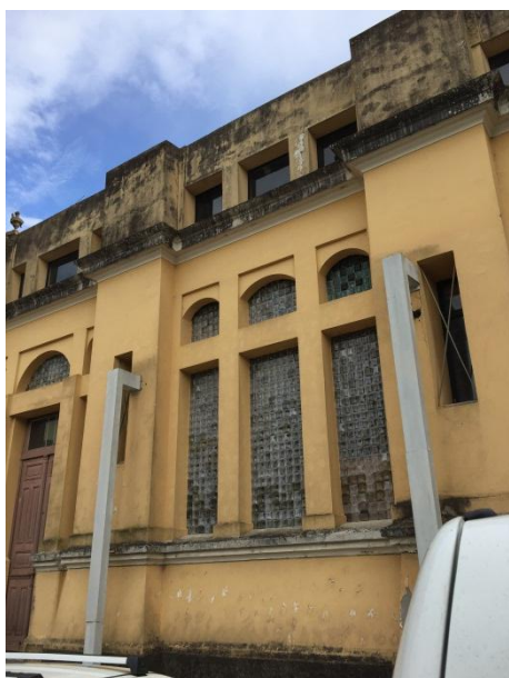
Figura A23 – Reentrâncias laterais e saliências da ala esquerda da ala esquerda da fachada sul – trecho t2 - vista 1
