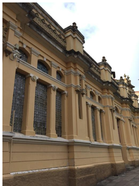
Figura A15 – Reentrâncias laterais e saliências da ala esquerda da fachada norte - trecho t2 - vista 2
