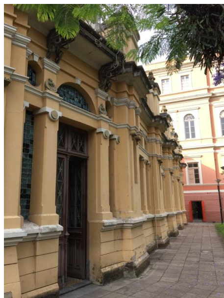
Figura A9 - Reentrâncias laterais e saliências da ala direita da fachada norte - vista 2 - trecho t3 e do torreão (amostras adjacentes à fachada norte) - vista 2
