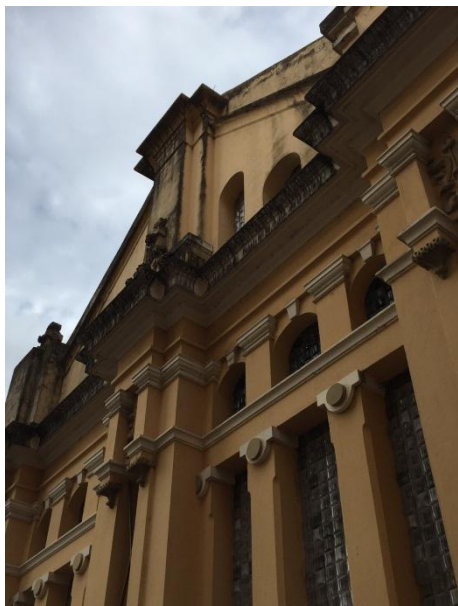
Figura A18 – Reentrâncias laterais e saliências da fachada leste - vista 1 - detalhe região de topo
