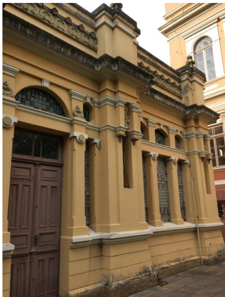
Figura A6 - Reentrâncias laterais e saliências da ala direita da fachada norte - vista 2 - trecho t1
