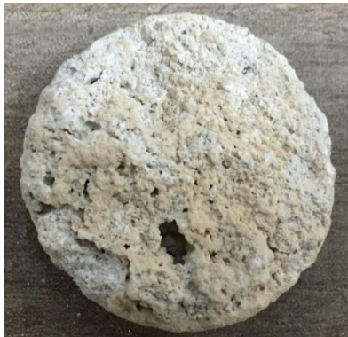
Figura 54 - A2 - porção 2 - face externa
