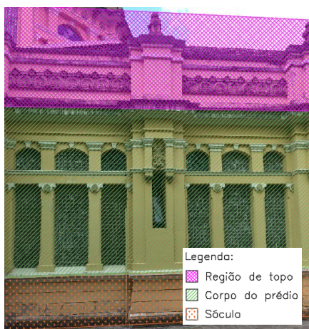
Figura 102 - Divisão da fachada em regiões
