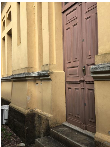
Figura A33 - Reentrâncias laterais e saliências da ala direita da fachada sul - vista 1 - detalhe sóculo
