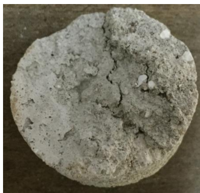
Figura 66 - A4 - porção 4 - face externa
