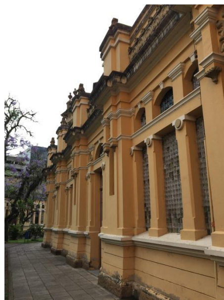
Figura A5 - Reentrâncias laterais e saliências da ala direita da fachada norte - vista 1
