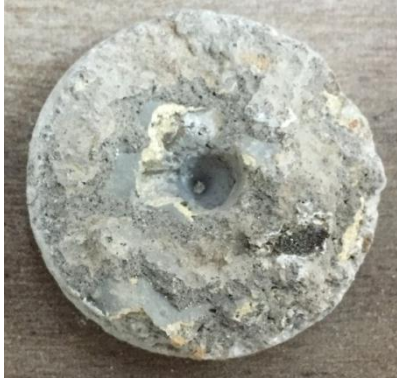
Figura 52 - A2 - porção 1 - face externa
