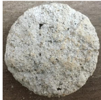
Figura 55 - A2 - porção 2 - face interna
