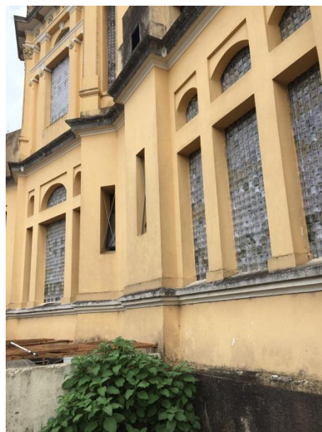
Figura A29 - Reentrâncias laterais e saliências do torreão (amostras adjacentes à fachada sul) - vista 1
