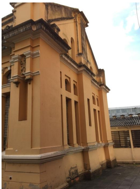
Figura A3 - Reentrâncias laterais e saliências da fachada oeste - vista 2
