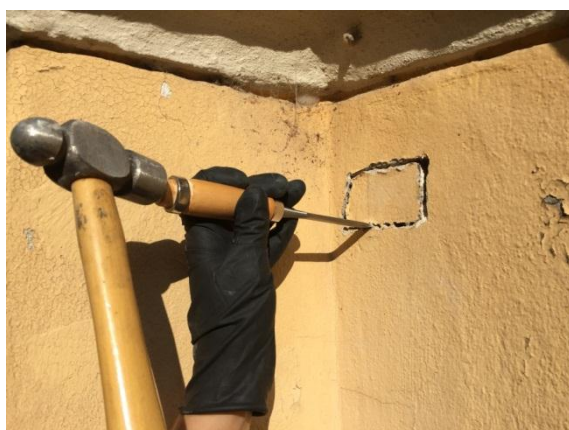
Figura 46 - Extração de amostra de argamassa com formão e martelo
