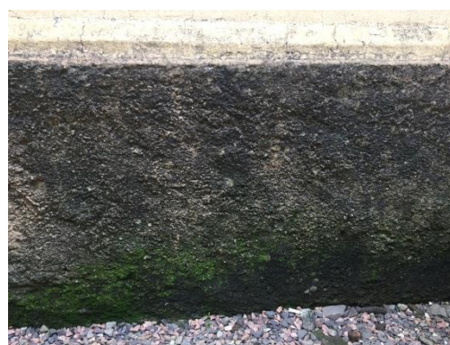
Figura 135 - Aparência real da fachada sul - ala esquerda em região analisada com termografia apresentada pela figura 134
