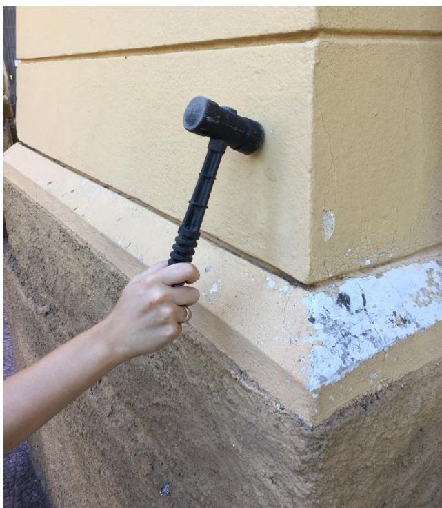
Figura 43 - Martelo de borracha e ilustração da execução do ensaio de percussão
