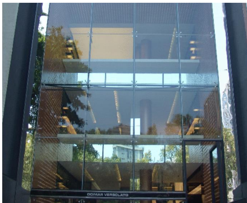
Figura 29: Edificação com fachada sistema spider glass
