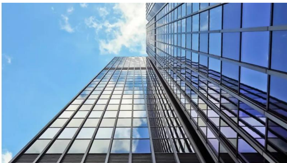
Figura 23: Edificação com fachada cortina tradicional
