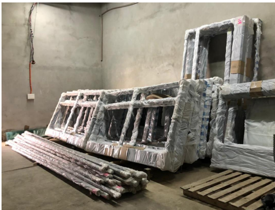
Figura 64: Armazenamento dos materiais em obra
