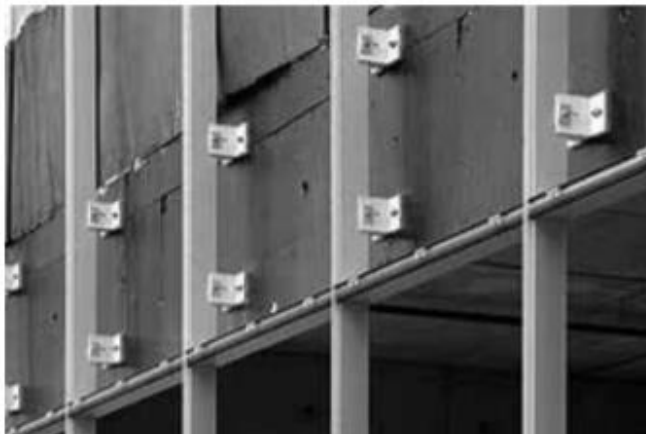
Figura 25: Fixação de ancoragens e estrutura auxiliar da fachada stick
