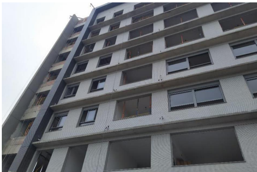
Figura 62: Primeiras esquadrias instaladas - Fachada principal
