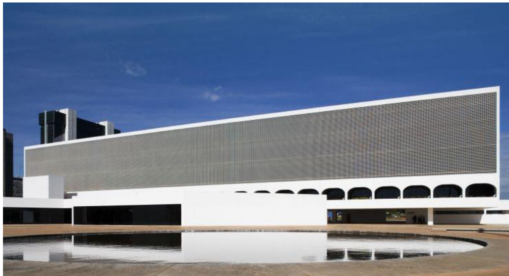
Figura 1: Biblioteca Nacional de Brasília – fachada com Cobogós. Projeto Oscar Niemeyer.
