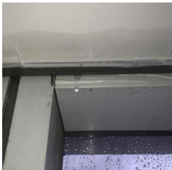
Figura 102: Falha na regulagem da Maxim-ar
