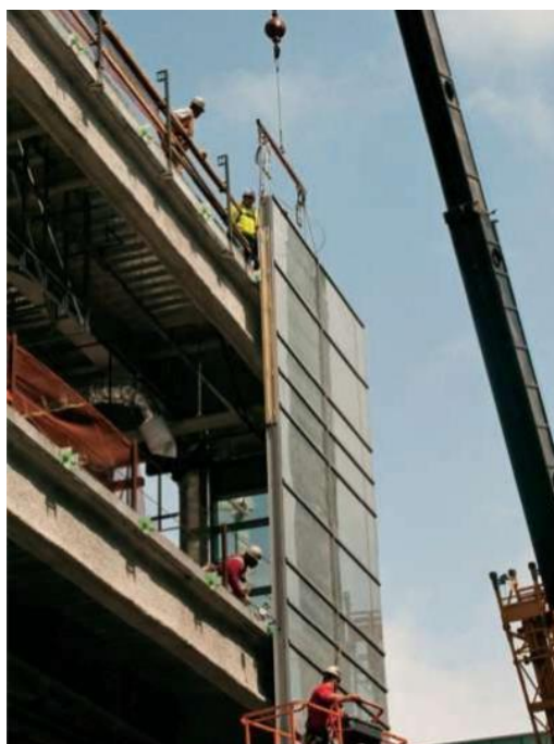
Figura 27: Içamento e instalação de módulo de fachada unitizada
