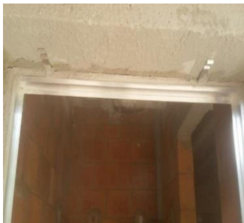
Figura 75: Chumbamento do contramarco
