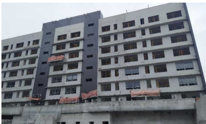
Figura 63: Primeiras esquadrias instaladas - Fachada secundária
