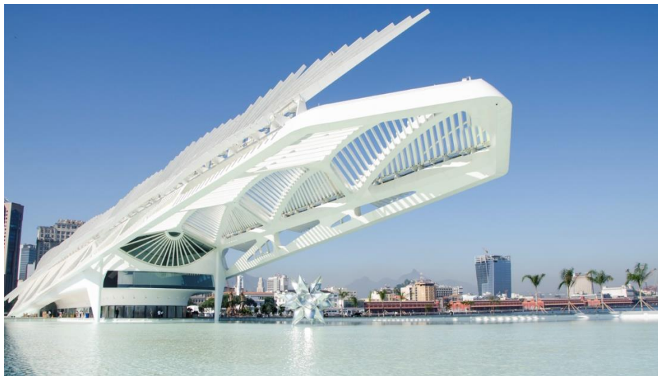
Figura 2: Museu do amanhã Rio de Janeiro – Brise Soleil com placas fotovoltaicas
