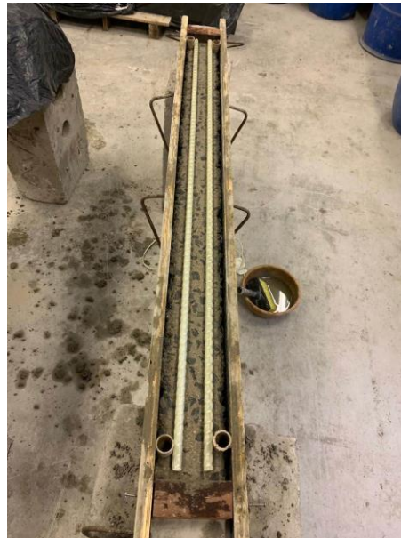
Figura 26 - Forma para execução de reforço de uma das vigas
