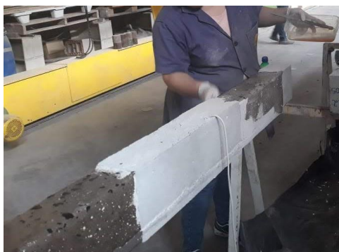
Figura 30 - Aplicação do primer na superfície onde a manta foi colocada
