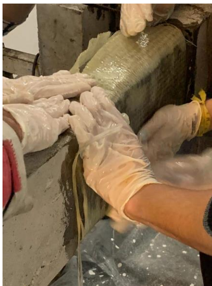
Figura 32 - Aplicação da manta de fibra de vidro
