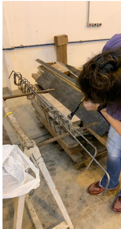
Figura 20 - Amarração dos estribos nas armaduras longitudinais
