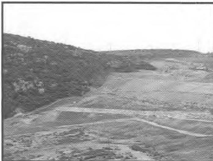
Figura 21 – Vista do vertedero de Garraf com detalhe da capa betuminosa selante (acima e a esquerda da foto);
