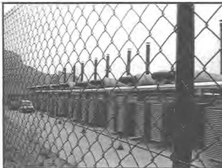
Figura 16- Vista dos geradores de energia elétrica a partir do bombeamento do gás gerado no AS de Garraf (Barcelona/ES);
