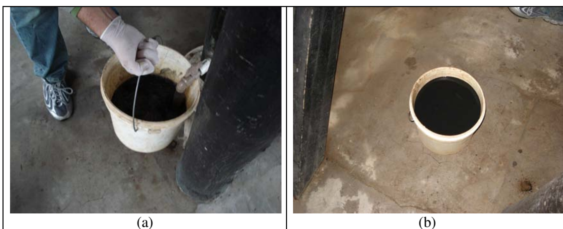
Figura 5.30 - Remoção de lodo da câmara anaeróbia (a) lodo sendo removido (b) Volume total de lodo removido neste ponto.
