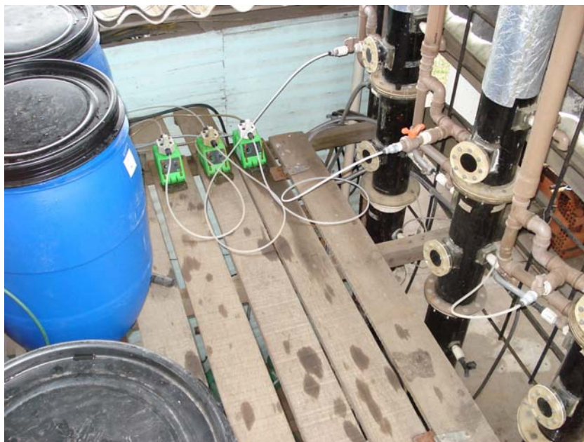
Figura 4.6 - Detalhe de dosagem de acetato de sódio na entrada da câmara anóxica.
