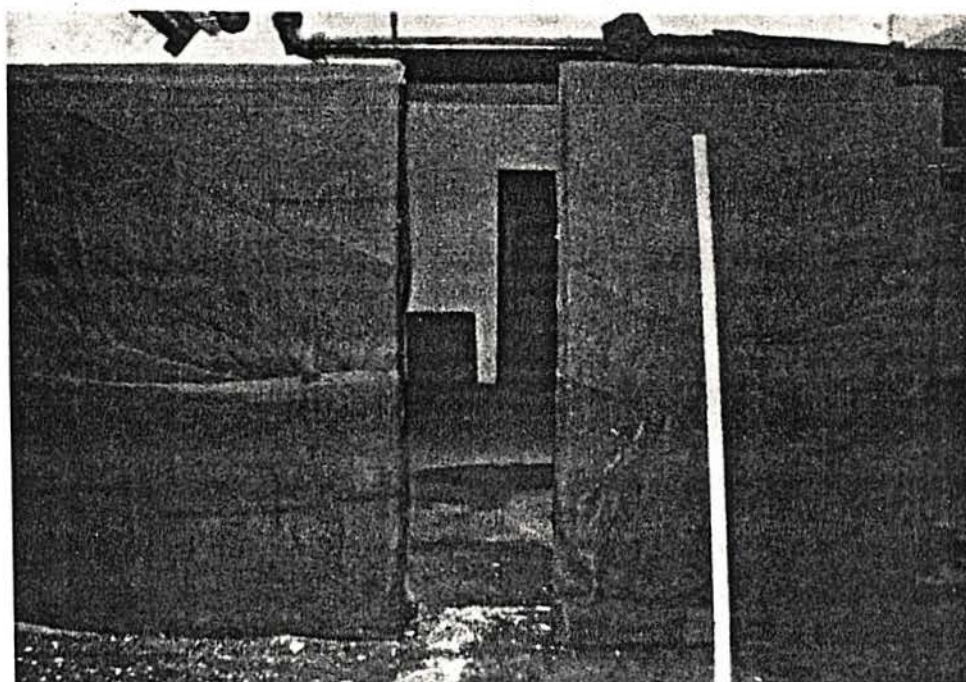
Foto 6.2 - Sistema de cura com emprego de saco de sarrapilha (aniagem) umedecido
