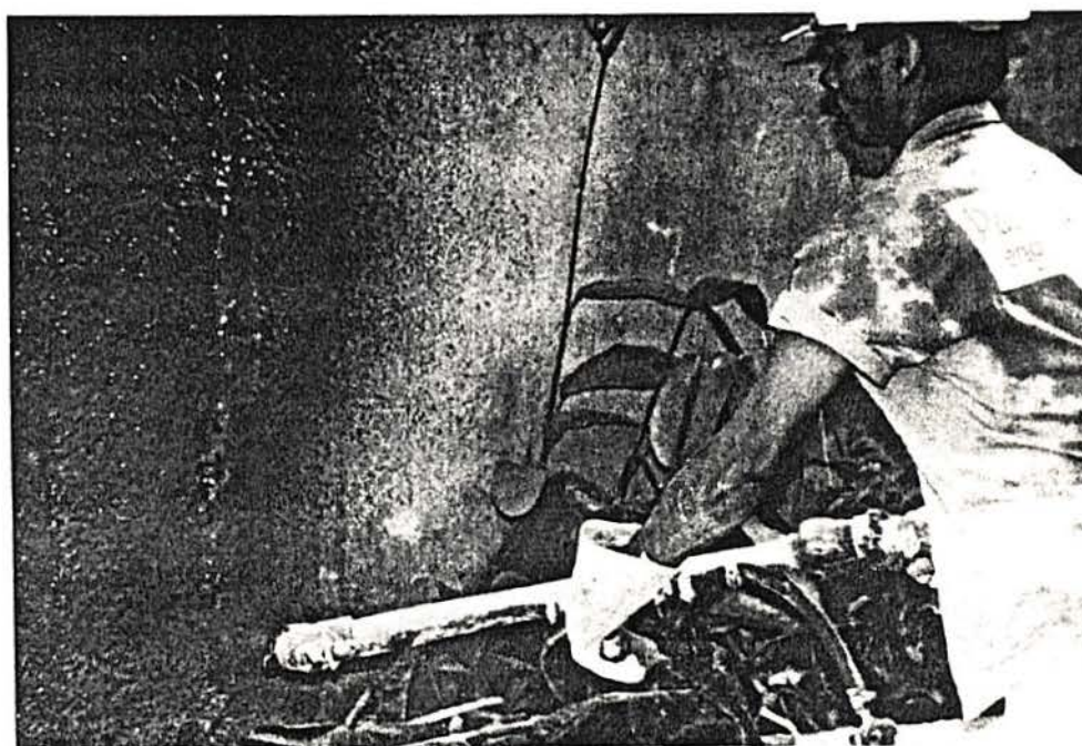
Foto 6.1 - Projeção de argamassa a ar comprimido -processo via úmida- em pilar
