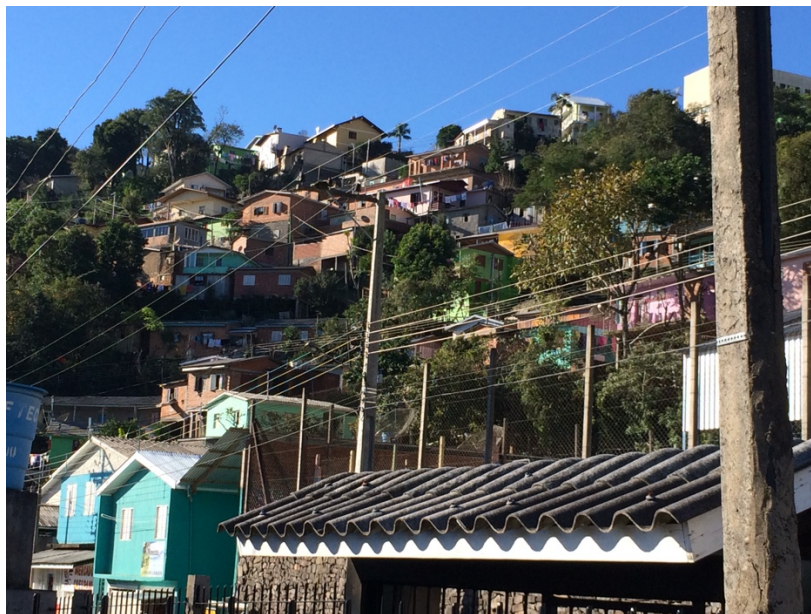
Figura 1 – Encosta íngreme ocupada de forma irregular
