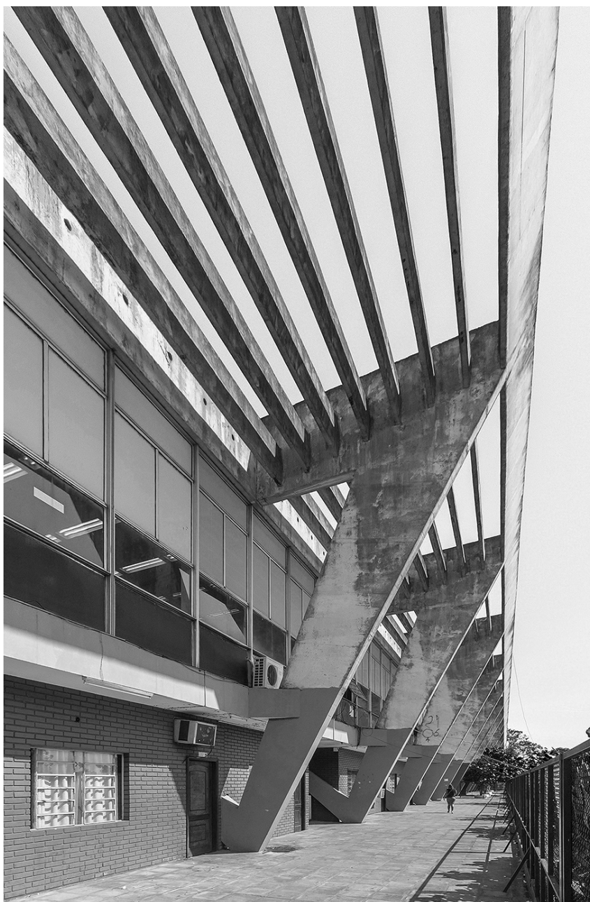
Fig. 32. Os pilares do bloco de salas de aula formam semi-pórticos transversais unindo, no mesmo elemento, pilar, viga de fixação da laje de cobertura e marquise; esta foi complementada por lâminas verticais que desempenham o papel de "brise-soleil". ►
