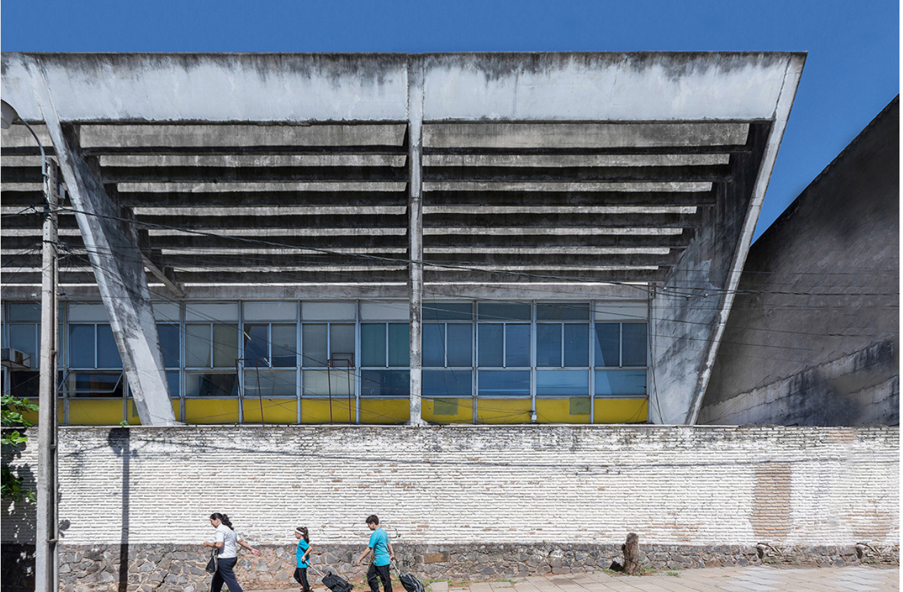
Fig. 16. Colégio Experimental Paraguai Brasil. Bloco de salas de aula, elevação norte. ▲
