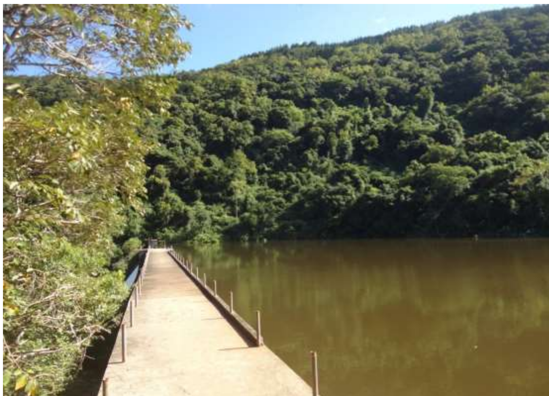
Figura 13. Vista frontal da superfície do reservatório.
