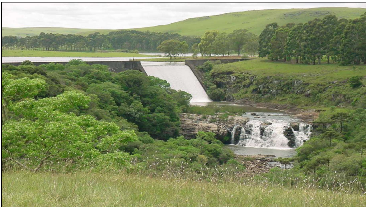
Figura 4-7 - EA4: saída do Reservatório da Divisa.
