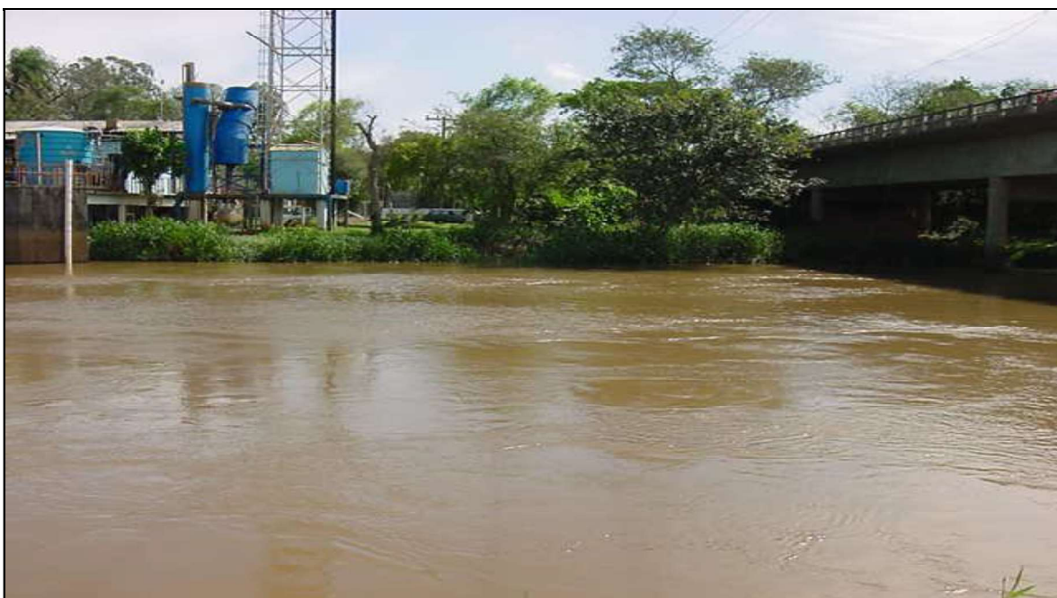
Figura 4-16 - EA 16: Rio dos Sinos (captação da COMUSA para o abastecimento do Município de Novo Hamburgo)
