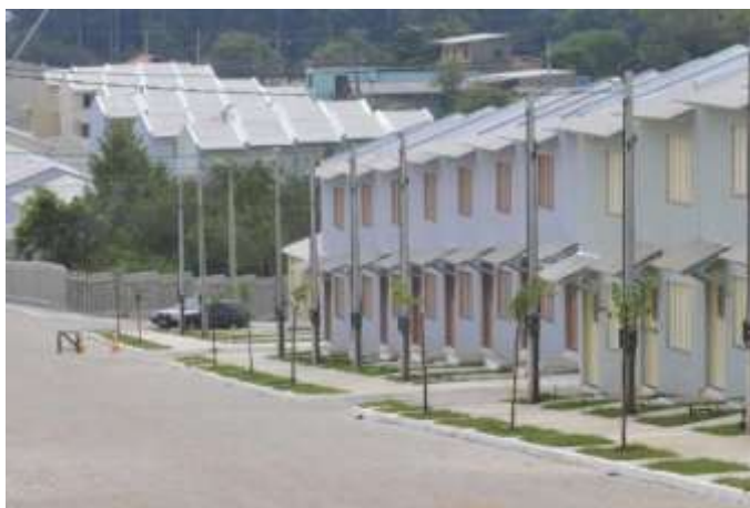
Fotografia 6 - Residências da Vila Nova Chocolatão em 2011:
