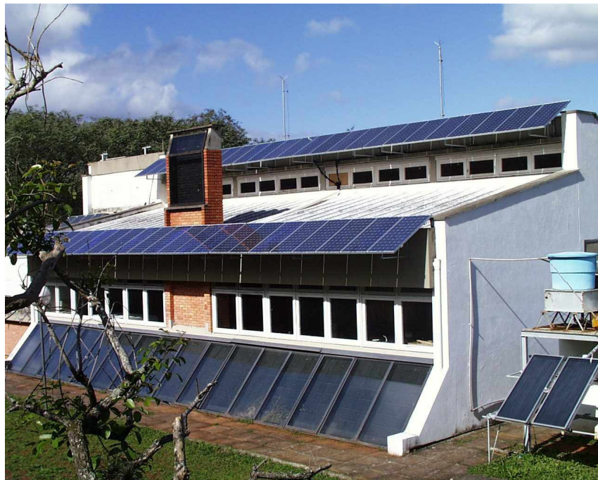
Figura 3.3 – Fachada Norte do prédio do Laboratório de Energia Solar - UFRGS
