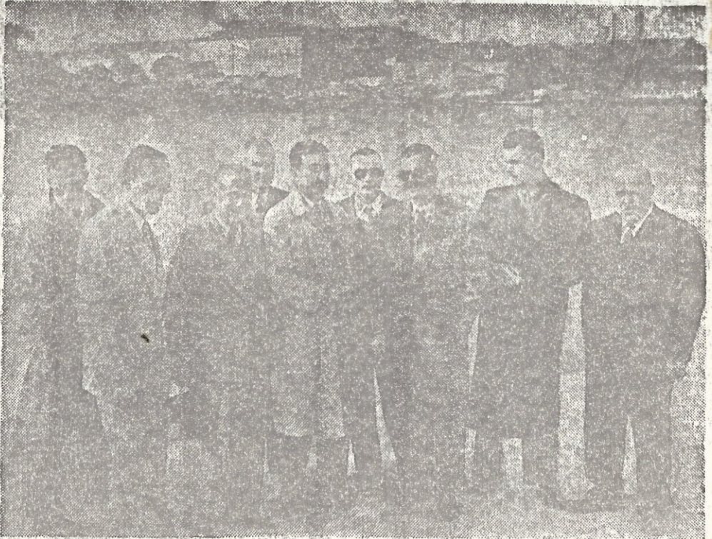
Grupo formado durante a visita de ontem, ás obras do novo cais, vendo-se ao fundo o local em que será construído o aterro-barragem, onde, possivelmente, serão instalados, provisoriamente, os clubes náuticos, prejudicados pela construção do cais
