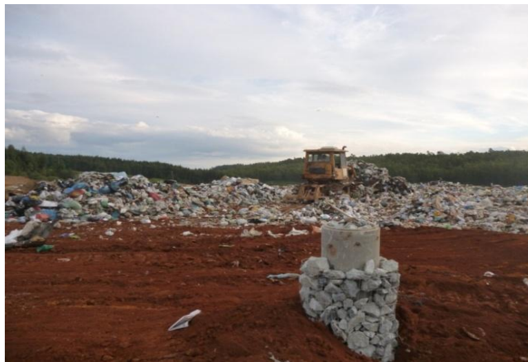
Figura 19 – Chaminé de captação e queima de gases Fonte: Acervo do autor
