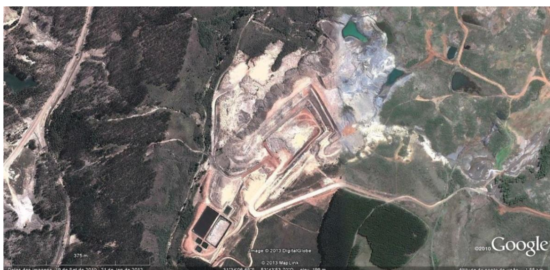
Figura 17 – Área do Aterro Sanitário de Candiota-RS - 18 de setembro de 2010 Fonte: Google Earth
