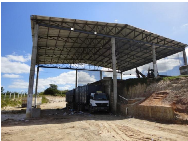
Figura 14 – Plataforma de transbordamento Fonte: Acervo do autor
