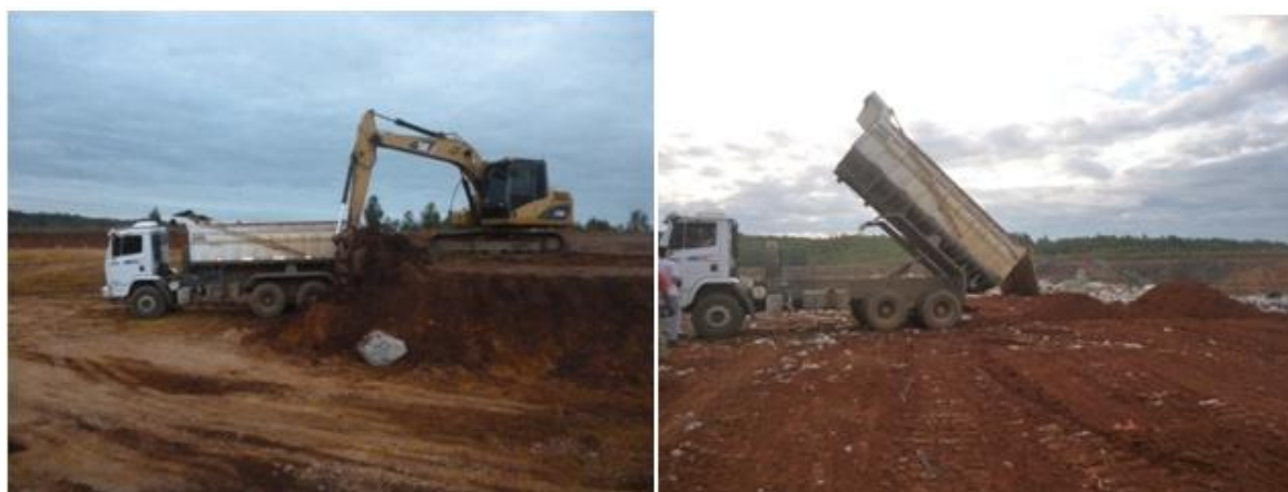
Figuras 20 e 21 – Carregamento e descarregamento de solo argiloso para recobrimento dos resíduos Fonte: Acervo do autor
