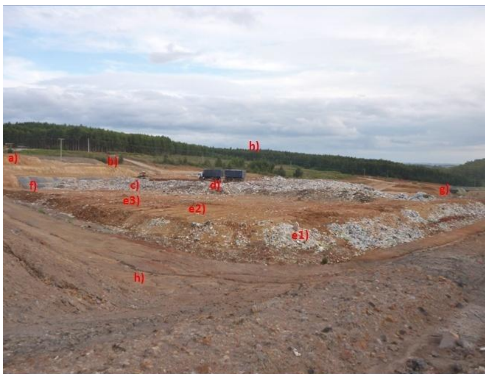
Figura 18 – Aterro Sanitário de Candiota-RS: Visão geral Fonte: Acervo do autor
