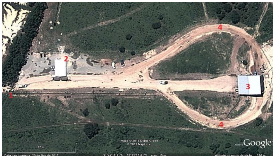
Figura 16 – A Estação de Transbordo de Pelotas-RS Fonte: Adaptado de Google Earth
